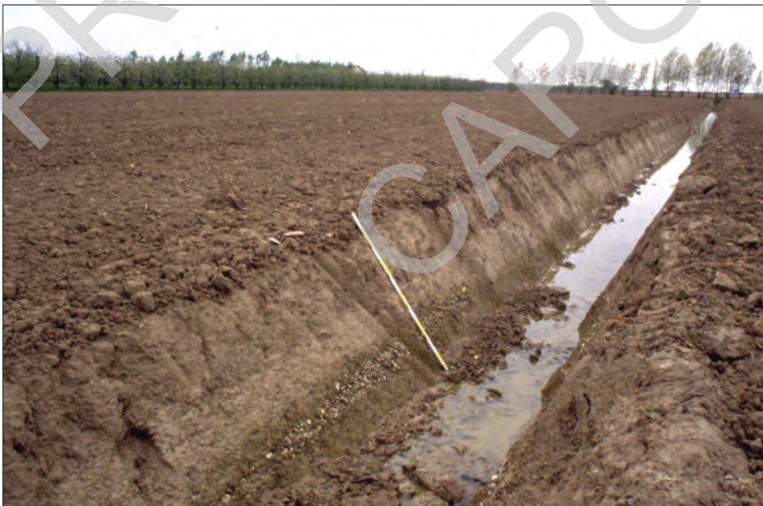
Fig. 52 - Concordia, Via 25 aprile, le ghiaie corrispondono al tracciato di una piccola strada romana che poggia sulla superficie LGM ed è sepolta dalle alluvioni medievali limoso sabbiose dell'unità di Torcello.
