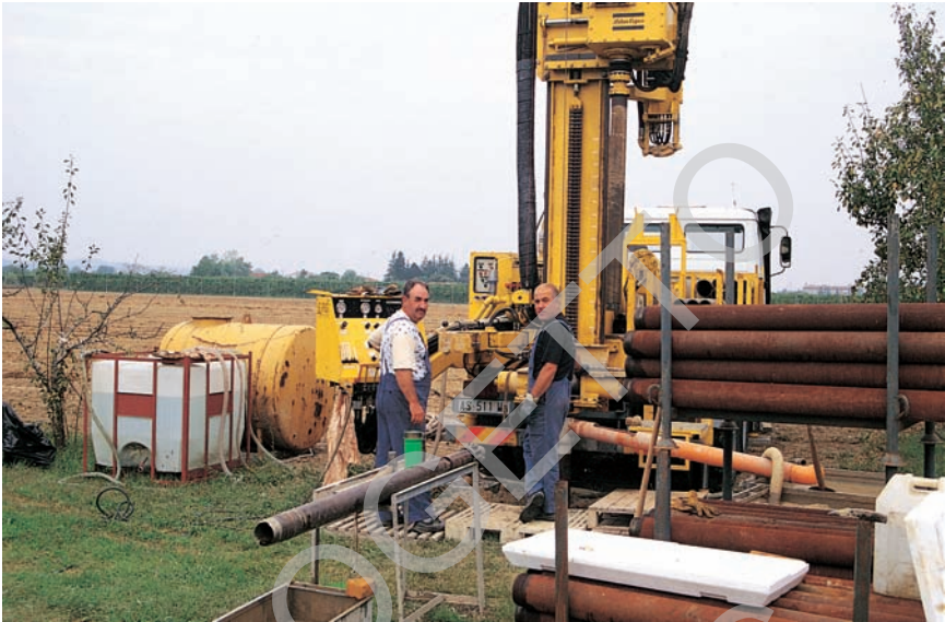
Fig. 7 - Cantiere allestito per l'esecuzione di un sondaggio profondo (sonda con carotiere doppio tipo wireline della ditta S.P.G. Adria usato in questo studio generalmente per profondità > 50 m,) realizzato per il progetto CARG.
