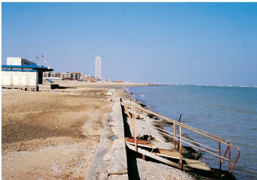
Fig. 27 - Fotografia del muro di sostegno della spiaggia sospesa posta al retro delle scogliere di Valverde di Cesenatico.
