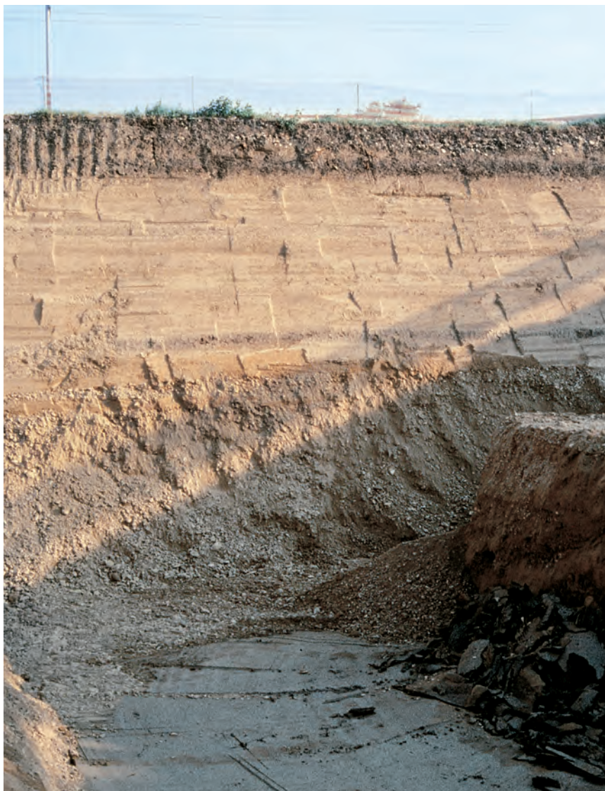
Fig. 14 - Fronte di scavo di circa 7 m per l'esecuzione di un sottopasso delle FFSS nei pressi di Santa Giustina (Rimini). La foto mostra un deposito di ghiaie di riempimento di canale fluviale (paleo-Marecchia) entro il Subsistema di Ravenna ( AES_8 ). Il canale poggia, in contatto netto ed erosivo, su dei depositi argillosi organici scuri (pavimento dello scavo in basso) ed è chiuso, in contatto netto, da sottili alternanze di sabbie, limi ed argille, ossidate, di tracimazione fluviale. La successione è chiusa da un orizzonte spesso circa 1 m con due suoli bruni sovrapposti. In questo caso l'unità di Modena ( AES_{8a} ) è mancante.
