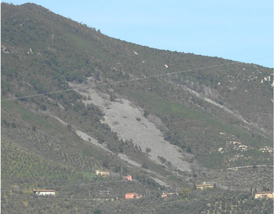
Fig. 10 - Detrito di falda poco a nord del paese di Agnano.
