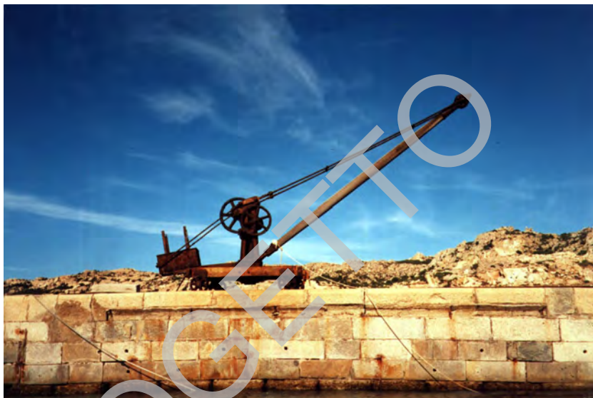
Fig. 32 - Opere di banchinamento portuale realizzate con il granito di Cala Francese. (Molo della cava).
