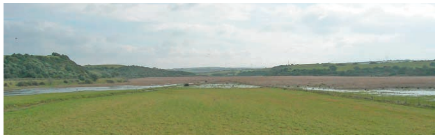
Fig. 60 - Tratto del Riu Ertas alla confluenza con il Riu Mannu oggetto di passati interventi di bonifica.
