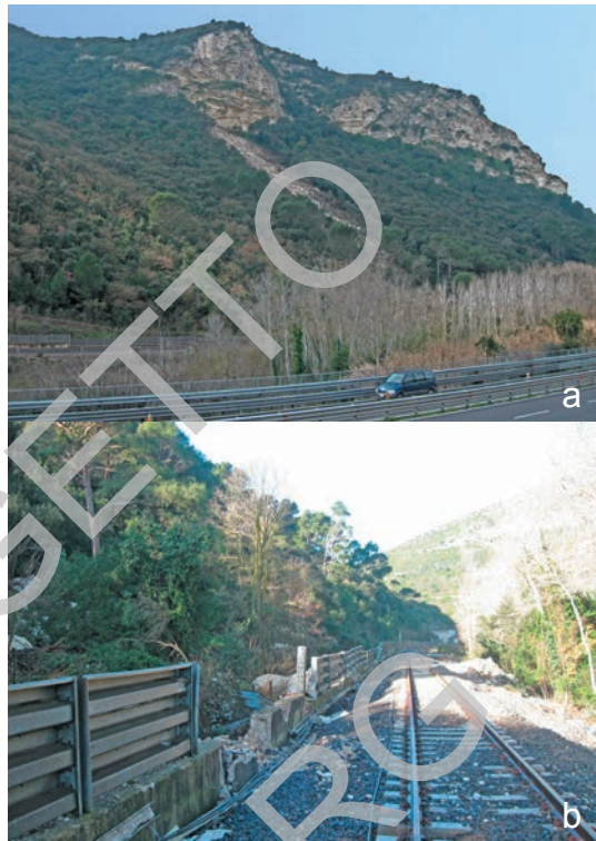
Fig. 78 - Frana di crollo della parete carbonatica nel versante orientale di P.ta Canechervu: a) nicchia di distacco e corpo di frana; b) effetti dell'impatto contro le opere di contenimento a protezione della ferrovia.
