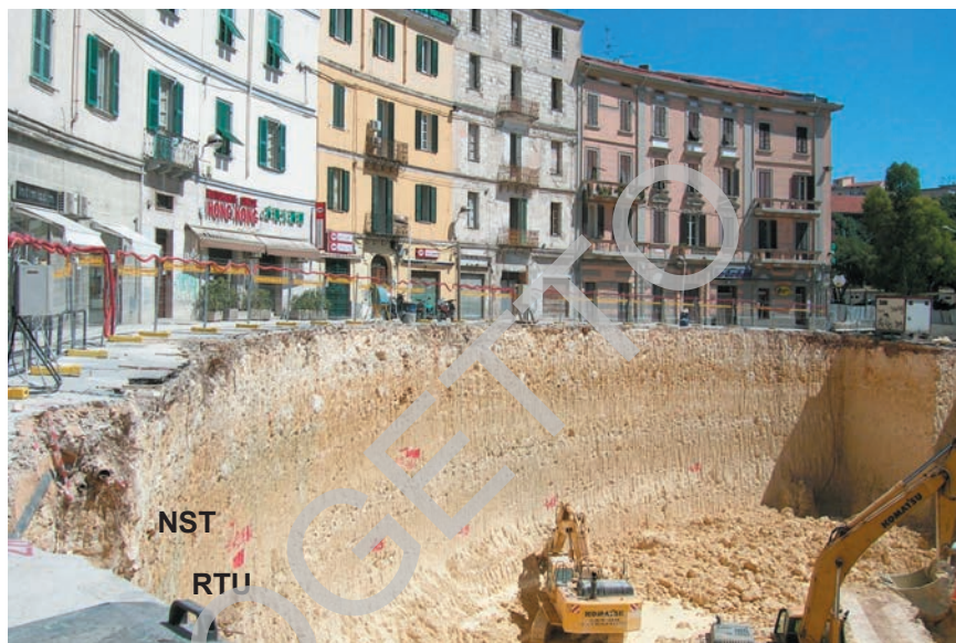
Fig. 48 - Contatto sfumato tra le marne della formazione di Borutta (RTU) e i calcari della formazione di Monte Santo (NST). Sassari, Emiciclo Garibaldi.
