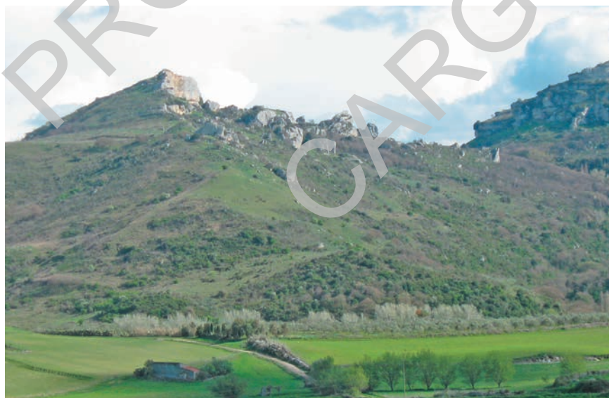
Fig. 54 - Loc. S'Elighe Entosu. In primo piano corpo di frana relitta coinvolgente i calcari della formazione di Mores (RES a ) e i sottostanti depositi della formazione del Rio Minore (LRM).
