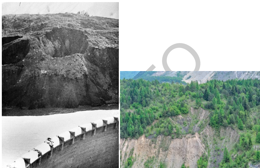
Fig. 90 - A sinistra: fenomeni di piping visibili presso la diga pochi giorni dopo la caduta della frana. A destra: morfologie attuali causate dai fenomeni di piping (diga del Vajont).
