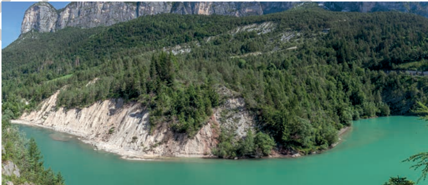
Fig. 86 - Panoramica dell'accumulo della frana di Pontesei.
