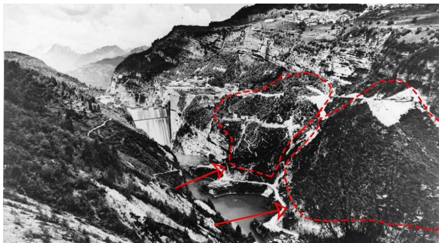
Fig. 52 - Panoramica della valle del Vajont con la diga in costruzione; sono evidenziate le due masse franate ("Colle Isolato") individuate da E. Semenza; le frecce indicano la posizione dei depositi alluvionali al di sotto del corpo di frana.
