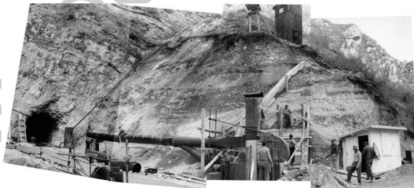
Fig. 53 - Imbocco occidentale della galleria di by-pass al Colomber; sono evidenti i depositi alluvionali alla base del "Colle Isolato".
