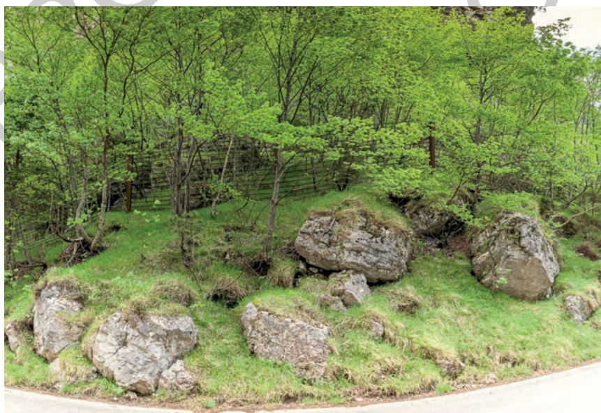
Fig. 70 - Accumulo di blocchi di dolomia della frana del Col Pizzon lungo la vecchia S.S. (Castei).
