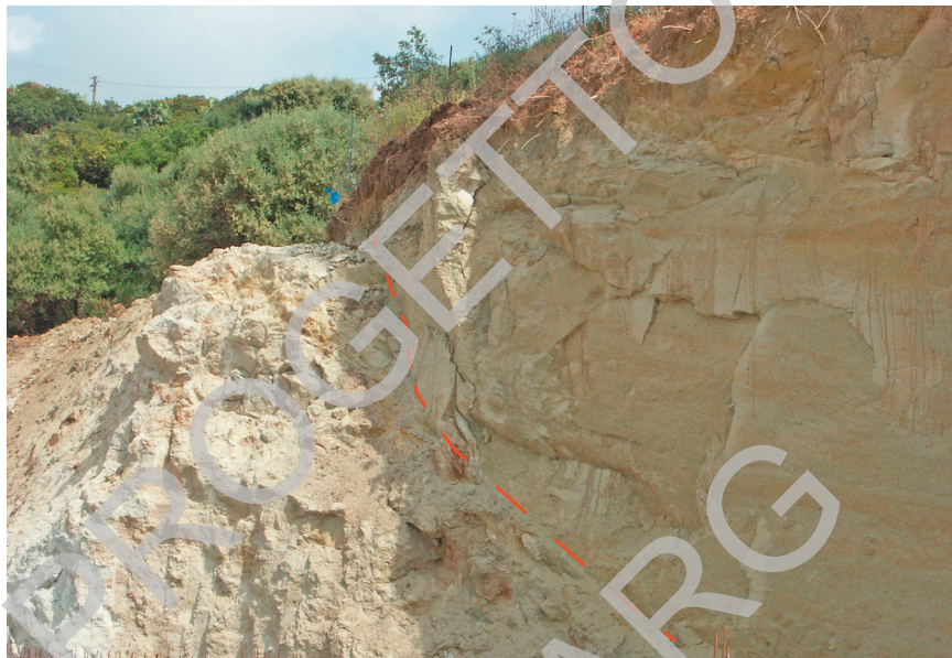
Fig. 48 - Faglia diretta che interessa la formazione di Fuile (Pliocene inferiore) alla periferia occidentale di Orosèi, al di sotto del rilievo del Gollài.
