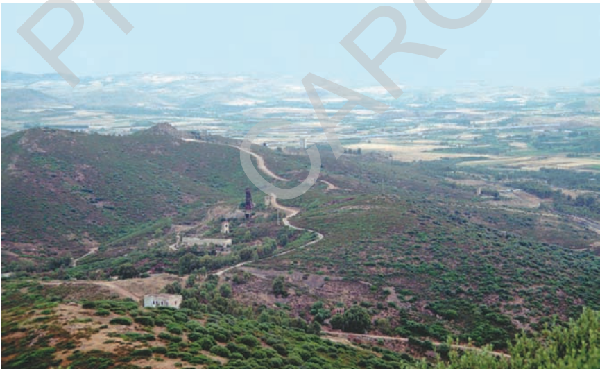
Fig. 80 - Loc. Perda Lai. Panoramica, vista dal Castello di Monreale, sulla miniera dismessa di fluorite di "Monreale".
