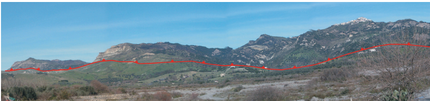
Fig. 4 - Panoramica del versante sinistro del Fiume Nicà, da SE verso NO, in cui è osservabile lo sviluppo della Falda di Cariati. Nel fondovalle affiora la successione serravalliano-tortoniana della formazione delle argille marnose del Ponda su cui sovrascorre la Falda di Cariati, che qui è costituita dal basso in alto da una successione argilloso-marnoso-arenacea torbiditica che passa in alto alla “Formazione Conglomeratico-Arenacea di Cozzo Cufali”.
