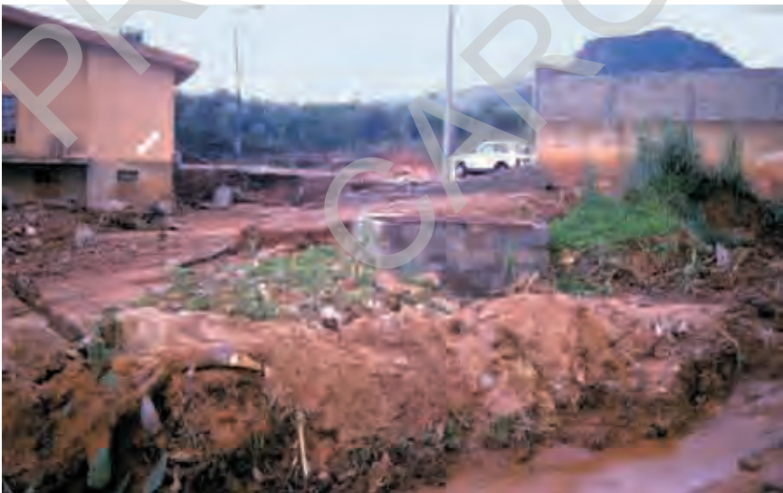
Fig.73 - Abitato di Capoterra nei pressi del campo sportivo: effetti dell'ondata di piena con indicato dalla freccia (sulla parete di una casa) il livello raggiunto dall'acqua e dal fango.
