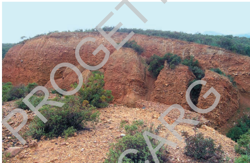
Fig. 143 - Località Valle Bacchellina. Frana di crollo indotta da modificazioni antropiche nei depositi del Pleistocene superiore ( PVM_{2a} ).
