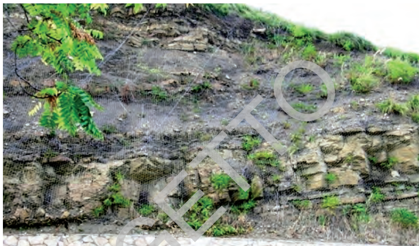
Fig. 37 – Tufiti di Tusa: alternanza marnoso-arenacea in strati medio-spessi. Loc.: sulla SP 54 Bis.
