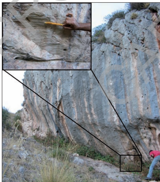
Fig. 52 - Faglia traspressiva destra che disloca i depositi silico-carbonatici della formazione Crisanti rispetto ai calcari della formazione Caltavuturo affioranti al letto della faglia. Rocca S. Felice, U.S.S. M. Cane–S. Onofrio.
