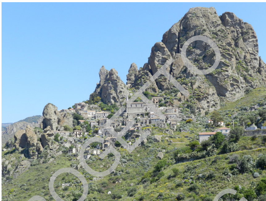
Fig. 49 - Panoramica di Pentidattilo e dei fenomeni di crollo e ribaltamento (conglomerati del flysch di Capo d'Orlando). Da notare la predisposizione geometrica allo scorrimento (a franapoggio) del contatto tra conglomerati e filladi del Paleozoico.
