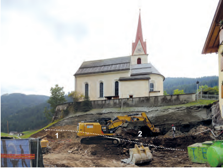
Fig. 124 - Scavi a nord della collina su cui sorge la Chiesa di St. Andreas, in cui si osserva il substrato roccioso composto da micascisti quarzosi (1) e, sopra e a destra (2), blocchi eterometrici prevalentemente di marmi a silicati. Località: Colle in Val di Racines.
