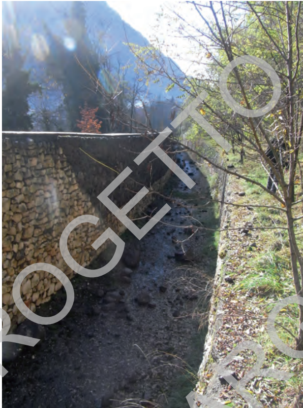
Fig. 96 - Prospettiva del vallo e del tomo in muratura a difesa dell'abitato di Condino (foto R. CAMPANA, 2010).
