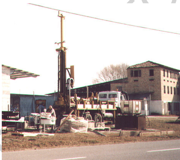
Fig. 31 - Immagine del cantiere e delle attrezzature utilizzate.
