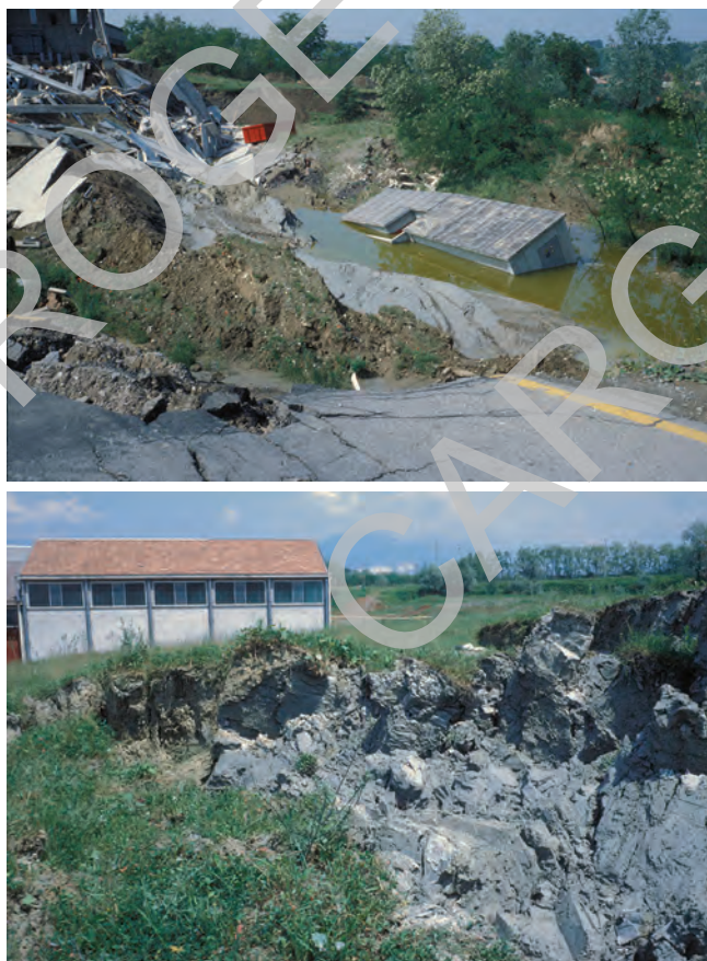
Fig. 33 - Briosco 1985, frana in depositi lacustri costituiti da argilla limosa (Foto A. Bini).
