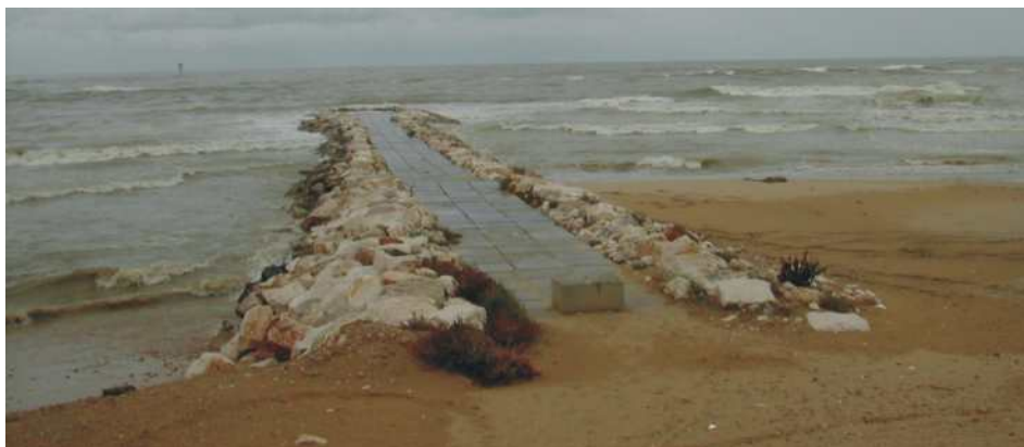
Figura 3.4.5: Casalbordino, Vasto (Di Risio M., Laboratorio di Ingegneria Ambientale e Marittima dell'Università de L'Aquila, Dicembre 2002): i pennelli causano un'alterazione del naturale bilancio di sedimenti trasportati lungo costa ad opera delle correnti litoranee. Dalle foto emerge chiaramente come la presenza di un pennello posizionato trasversalmente alla linea di riva ne alteri il suo andamento originario, provocando una deposizione di sedimenti sopraflutto (a destra della struttura nella foto) ed un'erosione sottoflutto (a sinistra della struttura).
