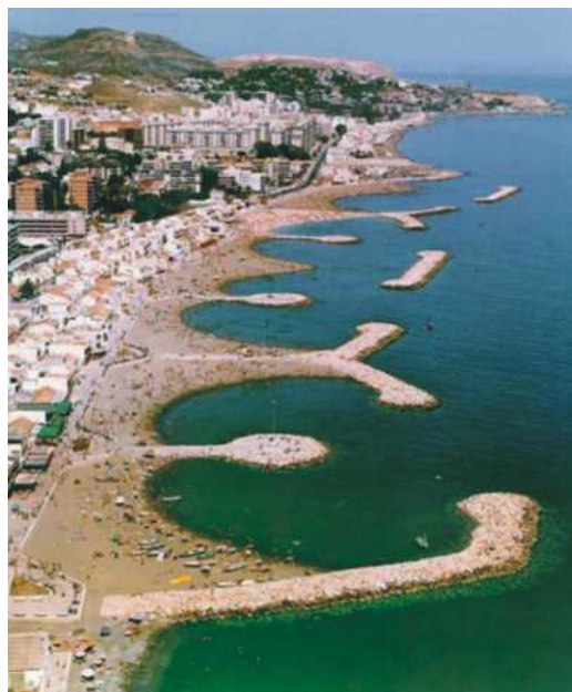
Figura 4.4.2: Spiaggia protetta con opere rigide. (Foto BeachMed)
