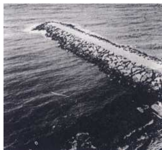
Figura 4.2.13: Sanremo. Pennello multistrato in massi naturali. Viene realizzato in paraggi esposti ad onde violente e con correnti di elevata intensità e capacità di trasporto. Tra la mantellata ed il nucleo è presente uno strato filtro intermedio. Tale strato impedisce l'asportazione del materiale fino costituente il nucleo della scogliera.
