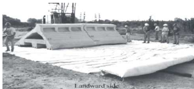
Figura 4.1.33: Modulo "Beachsaver Forte". Il lato mare della struttura è reso scabro dalla presenza di una serie di scanalature orizzontali aventi la funzione di disperdere l'energia dell'onda, mentre il lato terra, grazie alla sua elevata pendenza, consente alla sabbia di restare intrappolata dietro la barriera. La presenza del gradino superiore con fessure consente una canalizzazione dei flussi di acqua derivanti dalle onde incidenti, con successiva deposizione della sabbia trasportata. Questo effetto è tanto più marcato quanto più aumenta l'energia delle onde (es. mareggiate e tempeste).
