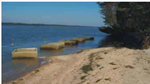
Figura 4.1.34: Barriere a cassone. Strutture in cemento preparate a riva per essere poi affondate in corrispondenza del sito previsto, in genere non molto lontano dalla riva.
