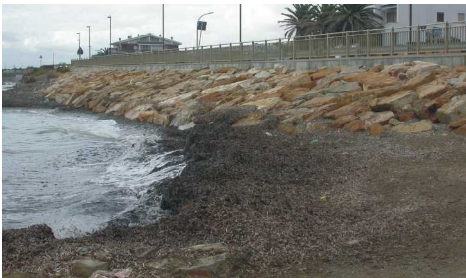
Figura 4.3.10: Rivestimento in massi. Spesso per limitare i danni alle infrastrutture viarie e ferroviarie causati da tempeste e mareggiate, si utilizzano rivestimenti con materiali di cava. La loro costruzione a ridosso delle massicciate viene eseguita con una disposizione più o meno regolare dei massi che ne aumenta la stabilità, mentre la loro conformazione superficiale irregolare consente una buona dissipazione dell'energia delle onde incidenti.
