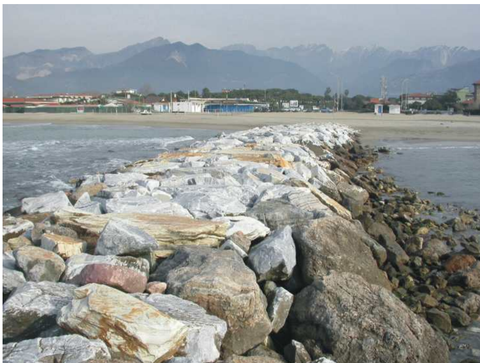
Figura 4.2.10: Vista verso terra di un pennello in pietrame. Nella costruzione di un pennello in massi naturali, l'ammorsamento nella zona di retrospiaggia avviene dopo la fase di scavo della testata lato terra. La presenza di un nucleo in tout-venant garantisce un assestamento dei massi di grandi dimensioni, disposti con mezzi meccanici, in modo da formare un solido incastro e dare una conformazione uniforme all'opera.
