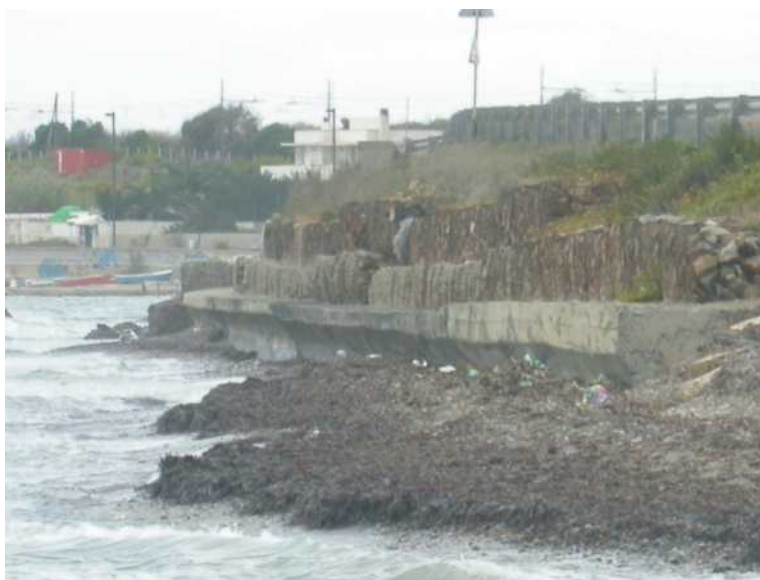
Figura 4.3.13: Esempi di protezioni di strade litoranee con rivestimenti in gabbioni. Nell'esempio a destra (litorale laziale) i gabbioni sono sistemati su un muro paraonde sagomato per riflettere l'onda incidente. Le gabbionature nei due casi assolvono anche ad una funzione di sostegno del terreno.
