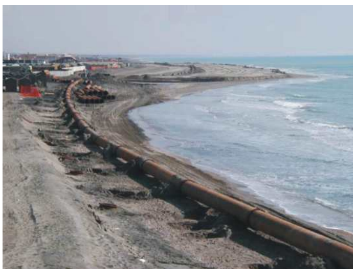
Figura 4.4.6: Particolare delle tubazioni utilizzate per il refluento di sabbia lungo l'arenile di Ostia nel 1999. (Foto Centro Monitoraggio Litorali Laziali).
