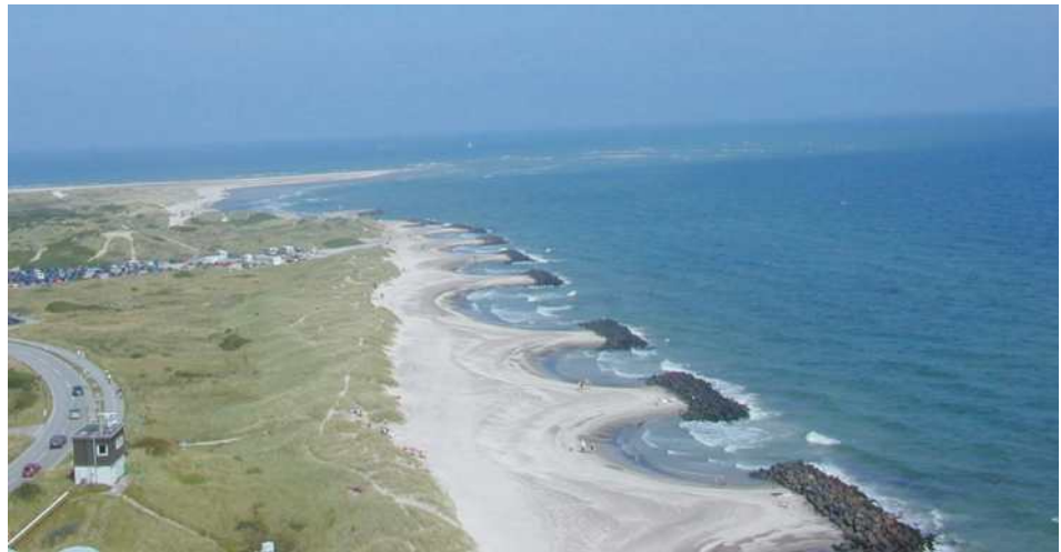
Figura 3.4.7: Skagen, Danimarca (Di Risio M., Laboratorio di Ingegneria Ambientale e Marittima dell'Università de L'Aquila, 2002): Serie di barriere distaccate emerse che hanno portato alla formazione di tomboli e cuspidi. Si noti come le onde frangono a distanze maggiori dalla riva in prossimità dei frangiflutti creando una zona di "ombra" lato terra, con conseguente accumulo del materiale trasportato lungo riva dall'azione combinata di onde e correnti. Funzionano egregiamente quando la costa sommersa è poco acclive.
