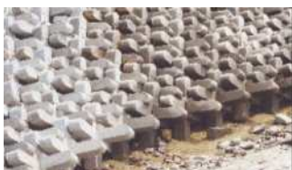
Figura 4.3.14: Rivestimento in Unità A-Jacks. In questa opera di difesa non è prevista la presenza di barre o cavi d'acciaio di collegamento, ma l'omogeneità dell'intera massa è data dall'elevata capacità che hanno i singoli blocchi di interconnettersi reciprocamente, formando quindi una struttura solidale.
