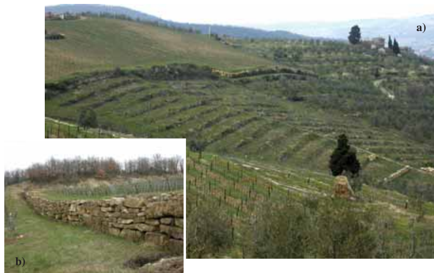
Figura 2.10 – Foto a) panoramica di una vasta sistemazione a gradonamenti, mediante l'utilizzo dei muretti a secco. Nella foto b) vista di un muretto a secco. Comune di Greve in Chianti (FI).
