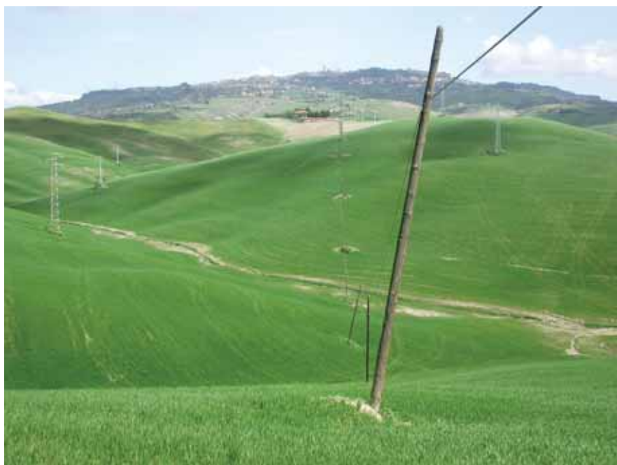
Figura 1.46 – Vista di una lunga fila di pali, per la linea elettrica, disarticolata dai soliflussi. Comune di Volterra (PI).
