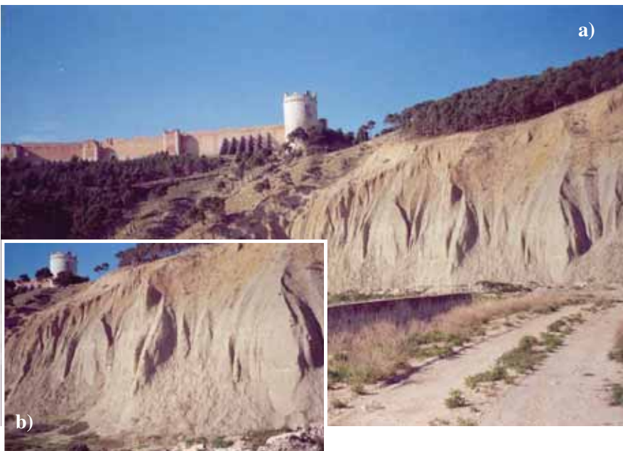
Figura 2.12 – Nella foto a) è visibile il fronte subverticale di una cava in depositi argilloso-limosi, situata alla base del rilievo sul quale sorge l'abitato di Lucera (FG). Dopo l'abbandono dell'attività estrattiva, avvenuto nel 1965, il mancato ripristino dei luoghi, caratterizzati dall'affioramento di depositi particolarmente erodibili e alterabili, ha creato le condizioni per l'innesco di diffusi fenomeni di dilavamento superficiale ( rill erosion e gully erosion ) associati a movimenti gravitativi (scivolamenti traslativi, crolli, ribaltamenti e colamenti) di limitata estensione (particolare in figura b). I fenomeni di dissesto progressivamente si sono estesi sull'intero versante, determinando un elevato livello di rischio per le persone, gli edifici pubblici (nelle foto si osserva la Fortezza Svevo-Angioina) e privati e le infrastrutture situate nella parte alta del versante stesso.
