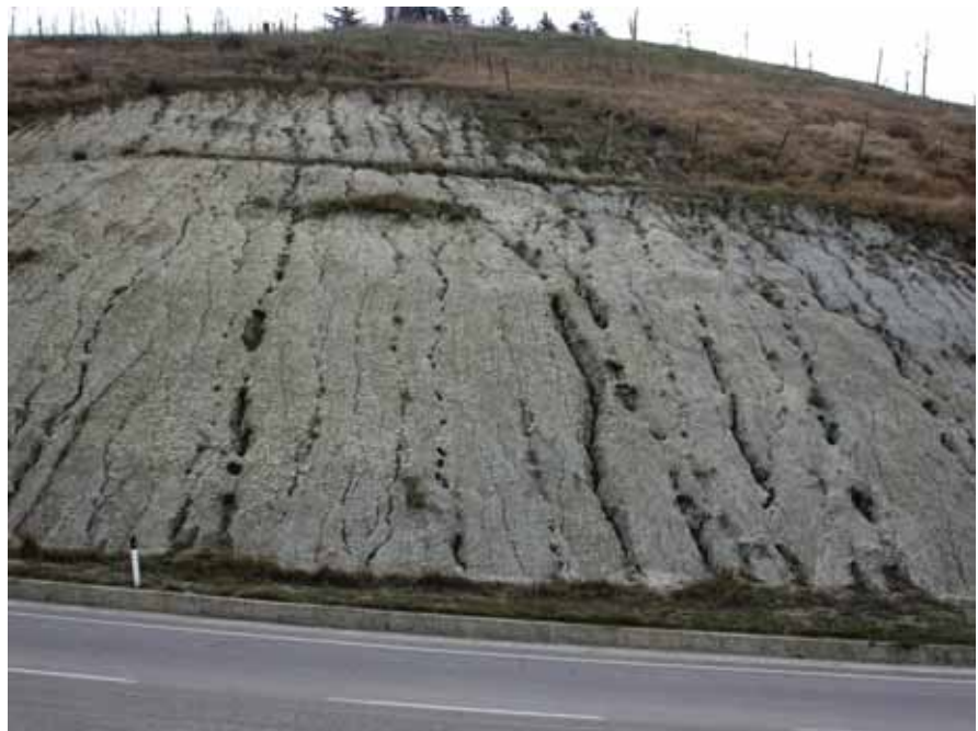
Figura 1.55 – Vista di una scarpata stradale priva di copertura vegetale e interessata da fenomeni di tipo rill erosion . Comune di Trivento (CB).
