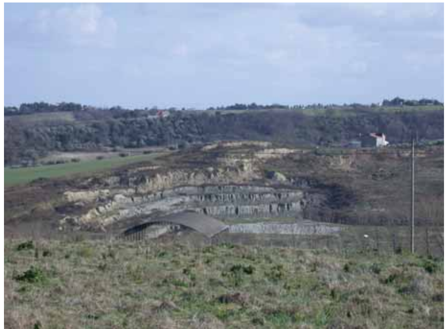
Figura 2.13 – Vista di un esteso movimento gravitativo che ha interessato un lato (destro nella foto) di una cava abbandonata. Comune di S. Giacomo degli Schiavoni (CB).
