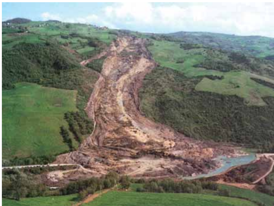
Figura 1.36 – Panoramica dell'esteso movimento franoso riattivatosi disastrosamente il 12 aprile 1996, in località Covatta, nel comune di Ripalimosani (CB). Il materiale messo in movimento, costituito prevalentemente da sedimenti terrigeni, nel corso di tale evento distrusse un tratto della S.S. n. 647 "Fondovalle del Biferno" e invase l'alveo del F. Biferno impedendo il deflusso, dando così origine ad un lago di sbarramento. Si tratta di una frana particolarmente articolata, classificabile come un movimento complesso, poiché si riconoscono scorrimenti rotazionali e traslativi evoluti in colamenti lenti. Tali movimenti gravitativi si sono riattivati ripetutamente causando una notevole retrogressione della zona di corona. Attualmente la Regione Molise sta realizzando imponenti interventi di sistemazione e mitigazione del rischio geologico-idraulico sull'intera area.
