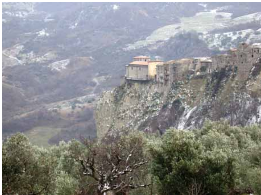
Figura 1.1 – L'azione combinata di fenomeni di dilavamento e gravitativi ha causato l'arretramento del versante e creato una scarpata molto acclive e di notevole altezza. Tale situazione geomorfologica ha generato un elevato livello di rischio per le abitazioni poste in corrispondenza dell'orlo della scarpata. Comune di Civitacampomariano (CB).
