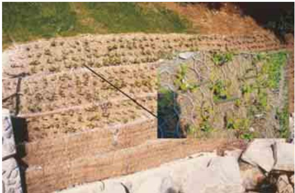
**Figura 6.3.19:** Intervento di ricostituzione di un versante prospiciente il fiume Reno. Al piede della scarpata è stata realizzata una terra rinforzata con paramento riempito in pietrame a gradoni con il duplice effetto di costituire una base stabile al terrapieno in terra rinforzata verde e di fornire la difesa all'erosione nel caso di piene.
