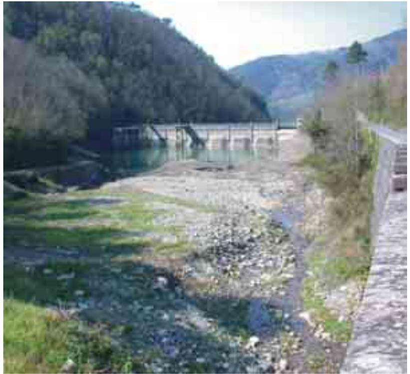
**Figura 3.1.3:** Serbatoio di piena di Vinchiana (LU). A sinistra, vista dell'uscita della galleria di deviazione del torrente per le normali portate, in alto lo sfioratore di troppo pieno dell'invaso. A destra vista dell'invaso da monte.
