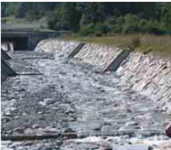
**Figura 6.4.4:** Rivestimento di fondo di un corso d'acqua, realizzato con pietrame calcareo, squadrate sistemato in maniera regolare.
