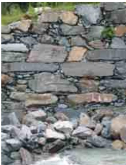
In genere il muro ha una sezione trapezoidale mentre la fondazione è rettangolare o trapezia in leggera contropendenza, con il paramento verticale posto a monte o a valle dell'opera, in funzione dei casi e delle necessità.
