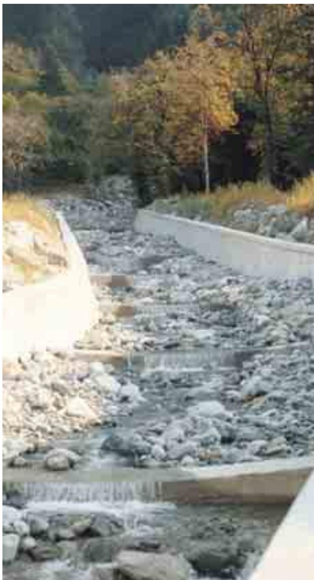
**Figura 6.1.36:** Le soglie vengono utilizzate anche isolatamente per controllare localmente la quota di fondo di un corso d'acqua. Questo avviene normalmente nei fiumi, presso i ponti, dove è necessario preservare le pile dallo scalzamento dovuto all'aumento di velocità dell'acqua ed all'evoluzione a più grande scala dell'alveo.
