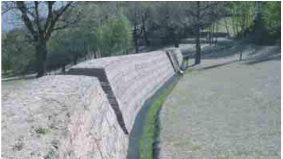
**Figura 7.1.9:** Una struttura di intercettazione chiusa posta a lato del percorso delle colate, il fango si riversa nella struttura attraverso uno sfioratore. Le sponde della vasca sono protette con muri in gabbioni di rete metallica a doppia torsione a maglie esagonali. (Quindici AV).
