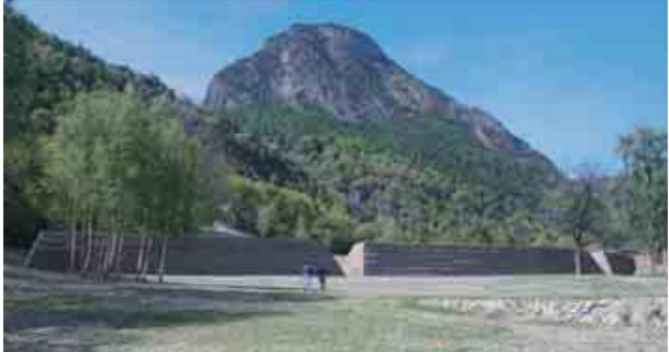
**Figura 7.1.8:** Il rilevato di intercettazione precedente visto da monte; le foto sono state riprese prima del rinverdimento e si può notare il canale per la raccolta delle acque superficiali che corre lungo l'opera, rivestito con una geostuoia tridimensionale, armata con rete metallica a doppia torsione, rinverdito.
