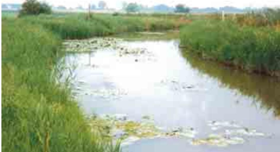
La pendenza dei canali di scolo segue possibilmente quella naturale del terreno, e diminuisce, col crescere della portata, dai colatori minori ai canali secondari ed al collettore principale. I valori caratteristici di pendenza variano tra 1 per 1000 e 0,05 per 1000 a seconda dell'ordine dei canali; le velocità medie corrispondenti alla portata massima sono rispettivamente variabili da 0,60 a 0,20 m/s.
