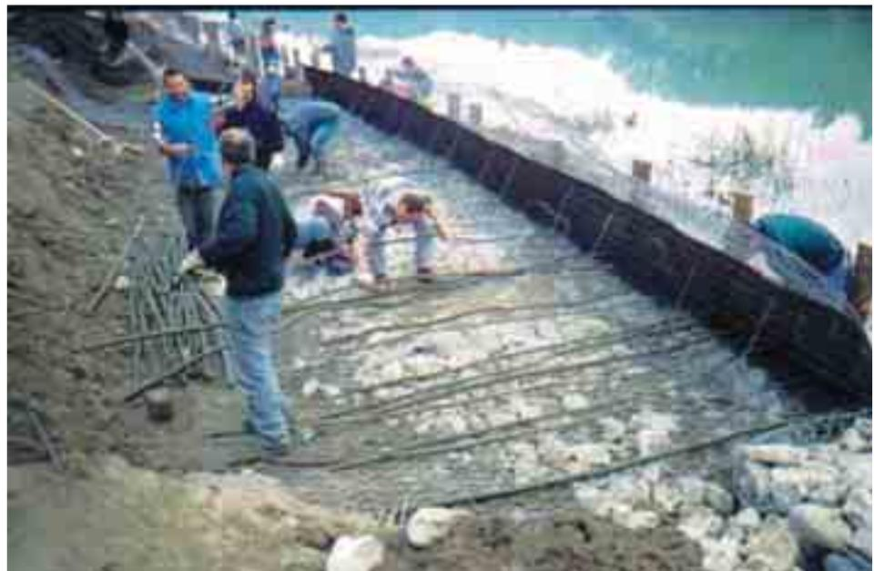
Le opere che si potranno realizzare con i sistemi descritti sopra saranno tutte caratterizzate da estrema flessibilità e quindi particolarmente adatte alle applicazioni di stabilizzazione delle sponde in frana. Le terre rinforzate a seconda dei sistemi utilizzati potranno inoltre essere permeabili all'acqua ed alla vegetazione.
