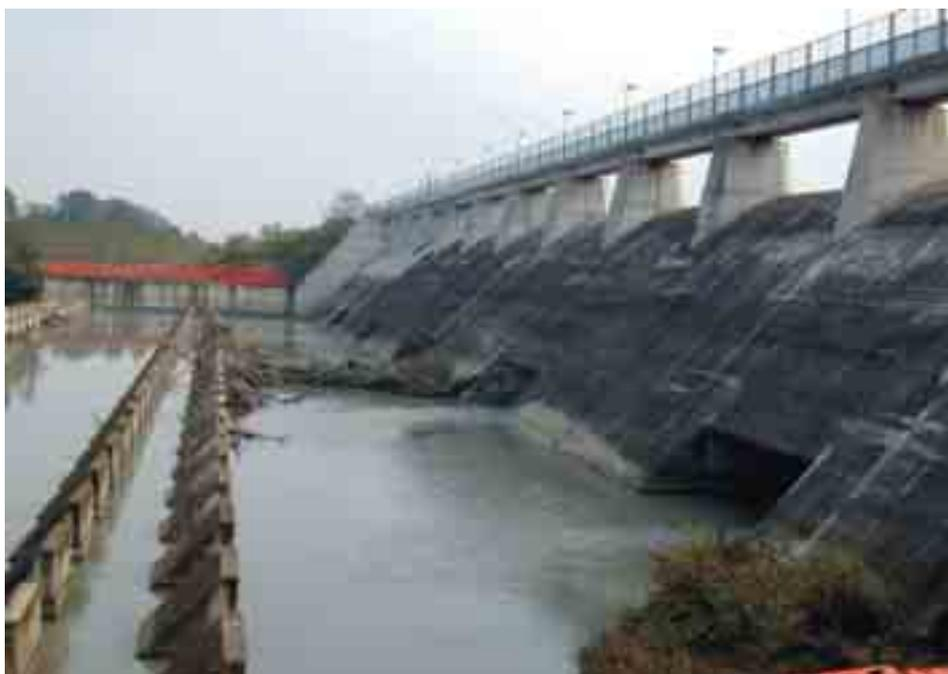
**Figura 3.2.3:** Cassa espansione torrente Chiani (PG). Vista dello scaricatore di fondo e di superficie
