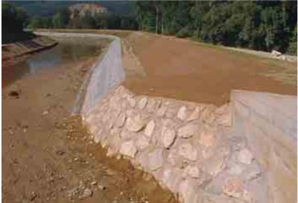
**Figura 6.4.22:** I materassi vengono facilmente colonizzati dalla vegetazione. La frazione limosa del trasporto solido intasa i vuoti tra i ciottoli e la vegetazione pioniera si instaura nel giro di pochi anni. Nella foto opera spondale in materassi in ambiente appenninico. A distanza di un anno è iniziata la colonizzazione spontanea.
