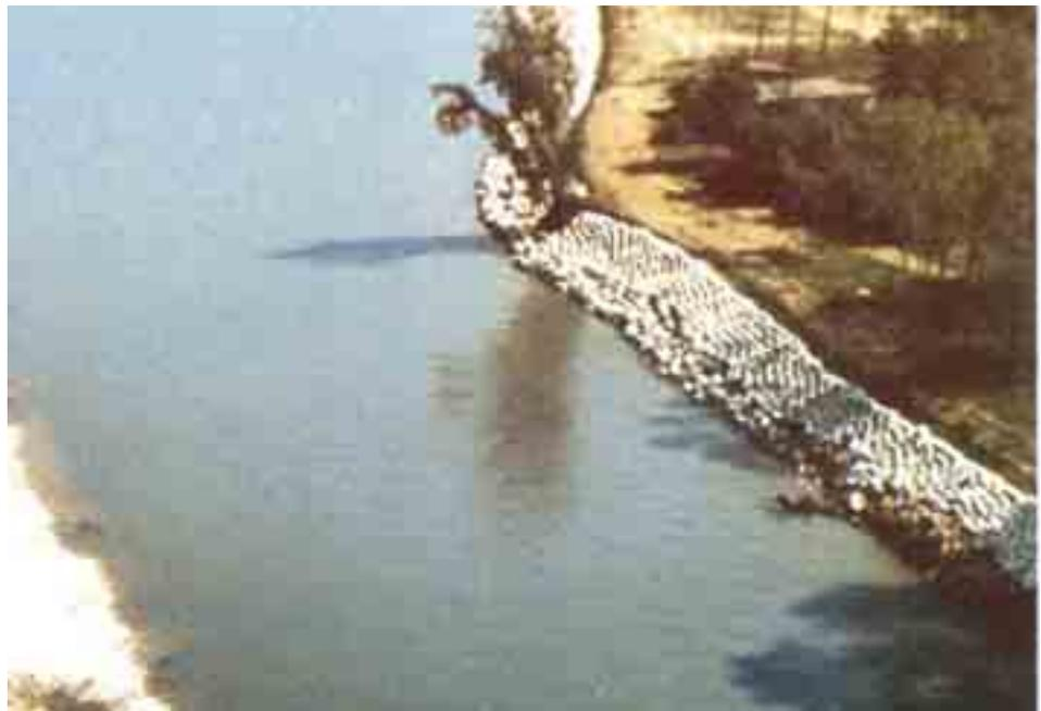
**Figura 6.4.11:** Lo spessore di una difesa in pietrame sciolto è proporzionale alle dimensioni del materiale che la costituisce generalmente non è inferiore a 0,30 m. Per garantire la stabilità rispetto all'erosione del fondo, il piede può venire adeguatamente approfondito. In alternativa si può realizzare un ringrosso di materiale che, nel caso di erosione, può andare a colmare il vuoto che viene a formarsi.
