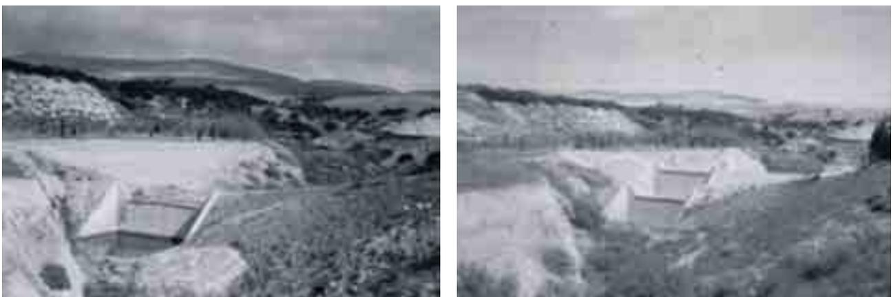
**Figura 6.1.31:** Esempio di briglia in terra con sfioratore in calcestruzzo. La foto in basso ripresa in un tempo successivo rispetto alla foto sopra, mostra il rialzo effettuato in seguito al riempimento della struttura inferiore. (da Puglisi & Trisorio-Liuzzi, 1992).
