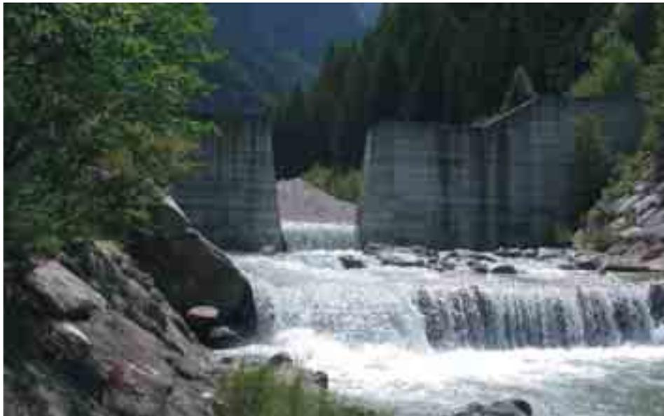
**Figura 5.1.10:** La foto mostra il comportamento di una piccola briglia a pettine in occasione di una piena. Il materiale legnoso si accumula a ridosso delle putrelle e l'acqua passa oltre. Se la briglia però viene completamente occlusa l'acqua è costretta ad aggirare l'opera con il rischio di scalzamento o di esondazione. Quando è possibile, in opere di piccole dimensioni, si può intervenire ad asportare il legname per mezzo di escavatori operando dall'alto.
