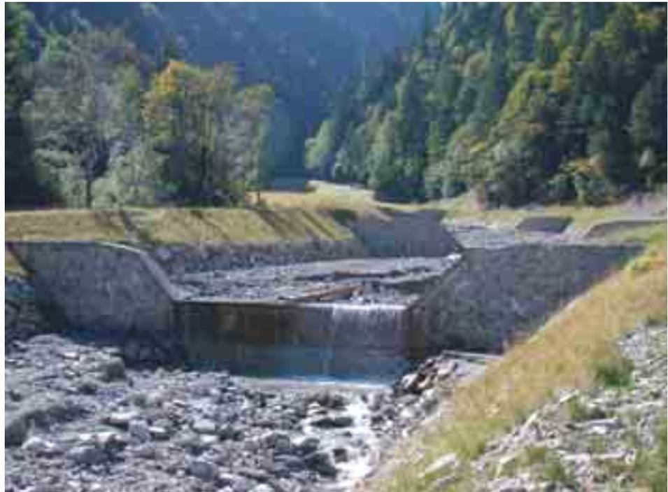
Le briglie sono soggette all'effetto delle sottospinte idrauliche a causa di moti di filtrazione dell'acqua nel terreno di fondazione della struttura.
