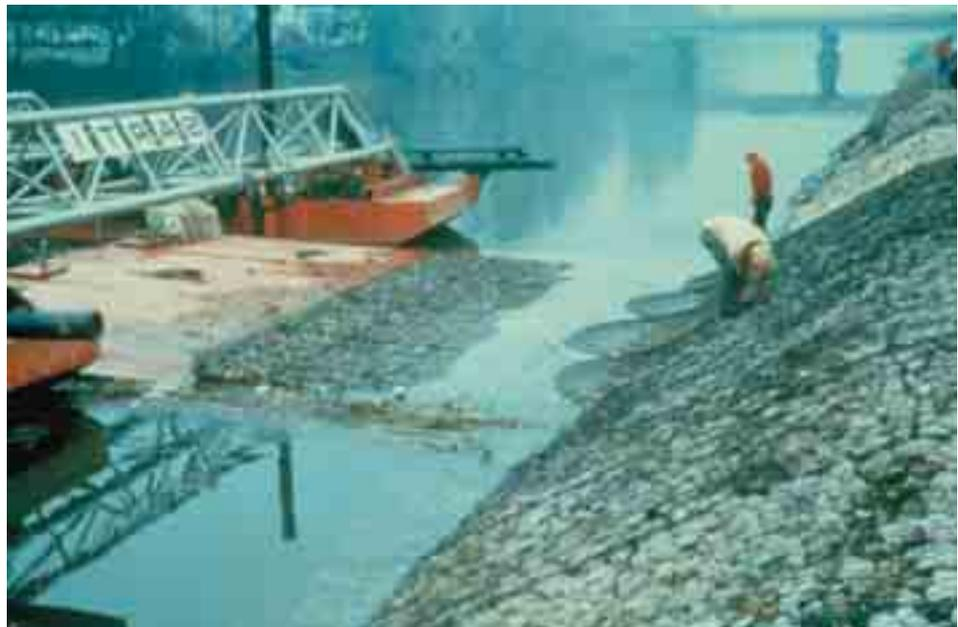
Anche per i materassi in rete metallica si presenta il problema della protezione per evitare l'aggiramento da parte della corrente. Il tratto iniziale e finale della materassata possono venire protetti con un setto realizzato con gabbioni, calcestruzzo o con massi legati con malta. Se il rivestimento è molto lungo è opportuno prevedere dei setti intermedi.
