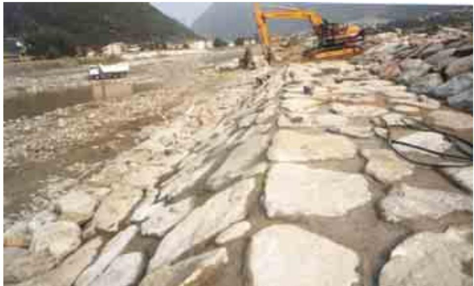
**Figura 6.4.15:** Una soluzione che consente di migliorare significativamente la resistenza al trascinamento della scogliera è quella di vincolare i blocchi con funi d'acciaio. Il sistema è allunga significativamente i tempi di realizzazione ed leva i costi dell'opera.
