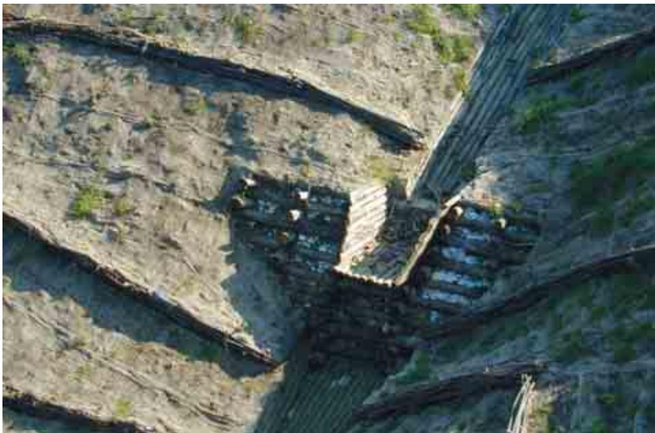
**Figura 1.7.1:** Complesso intervento di sistemazione e consolidamento dei versanti di un torrente montano in forte erosione. L'intervento ha previsto il ricorso a varie tecniche d'ingegneria naturalistica: rimodellamento del pendio, realizzazione di vimate, rivestimento del fondo dell'impluvio con tondame e costruzione di briglie in legname e pietrame, rivestimento con teli di biotessili ed inerbimenti.
