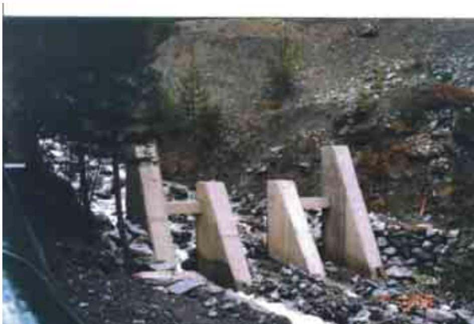
**Figura 7.1.5:** La stessa struttura precedente vista da monte. Si osservi il rivestimento in lamiera di acciaio speciale (acciaio T4) per la protezione contro i danni del trasporto solido.
