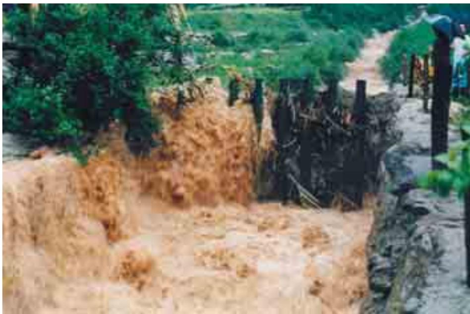
**Figura 5.1.11:** Le briglie a pettine sono impiegate soprattutto nei torrenti, dove il trasporto solido flottante può essere abbondante a causa delle caratteristiche dei bacini montani. In certe situazioni però le briglie a pettine possono venire impiegate anche nei grandi fiumi di pianura. E' questo il caso in cui sia necessario proteggere delle opere quali ad esempio le casse di espansione o i ponti. (Briglia a monte di una cassa di espansione lungo il Secchia)
