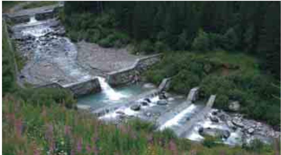
**Figura 1.8.2:** Consolidamento di un versante sottostante all'abitato di S. Mango sul Calore (Avellino). L'intervento ha comportato la stabilizzazione dell'asta torrentizia al piede della pendice, mediante salti di fondo e rivestimenti in gabbioni, mentre per garantire la stabilità del versante, si è fatto uso di terre rinforzate in 'Terramesh' in alternanza con opere di sola protezione superficiale tramite graticciate.
