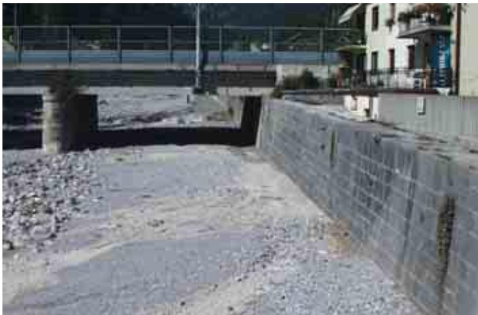
Il loro dimensionamento, la scelta del tipo di fondazione o di sottofondazione da adottare, è fatto sulla base delle verifiche delle condizioni di stabilità interna ed esterna del complesso "struttura - terreno di fondazione - terrapieno o scarpata", condotte secondo gli usuali metodi di calcolo adottati per le opere di sostegno a gravità.
