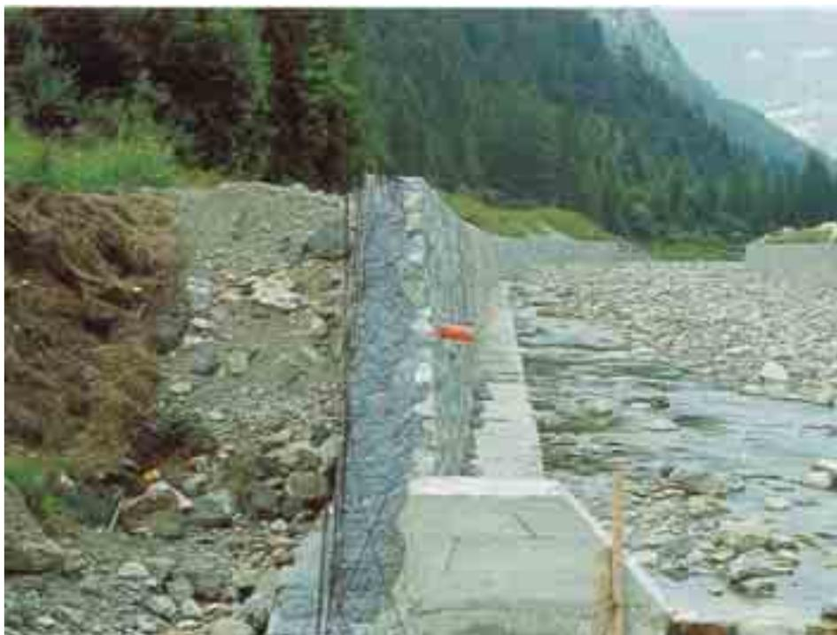
**Figura 6.3.11:** L'impiego di micropali consente intervenire con opere di sottofondazione anche strutture che hanno manifestato problemi di stabilità dopo la costruzione. L'inclinazione dei micropali oltre alle componenti verticali delle forze agenti in fondazione consente di assorbire quelle di taglio dovute alla spinta del terreno.
