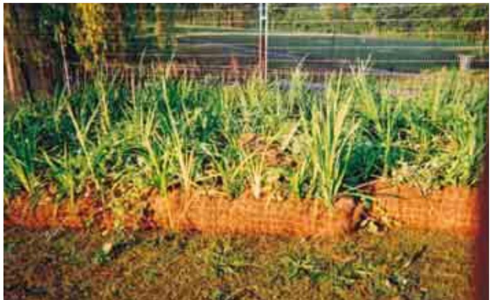
**Figura 6.5.12:** Il consolidamento della sponda si otterrà posando delle fascine di salici o di tamerici a tergo dei rulli ed eventualmente, al di sopra del livello dell'acqua, delle talee poste tra un rullo e l'altro.
