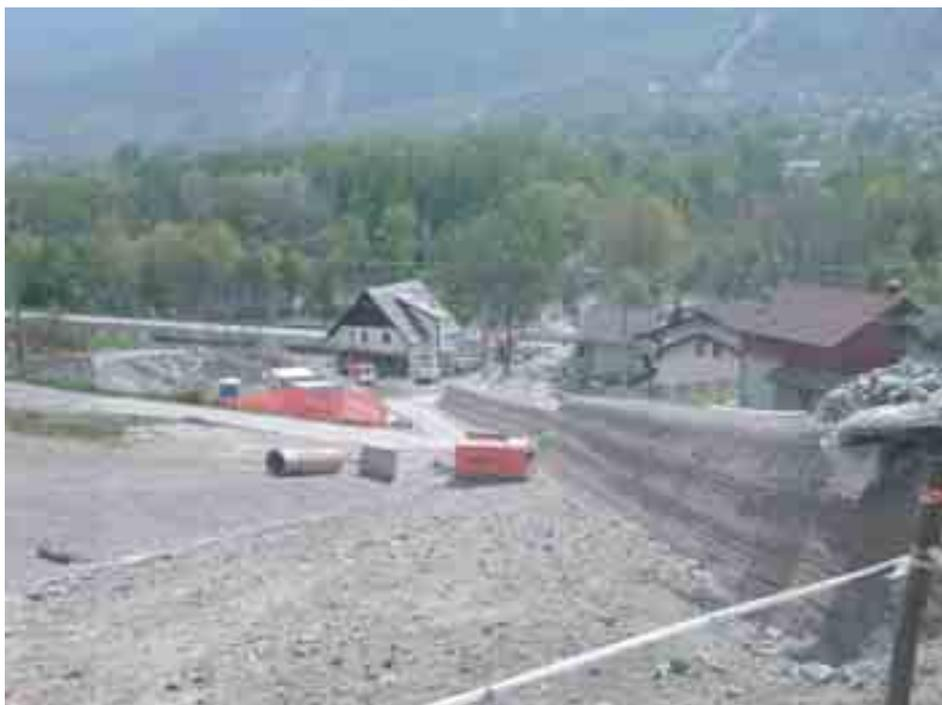
**Figura 7.2.3:** In certi casi a monte della struttura di deviazione si può creare una bassa struttura di intercettazione in grado di captare parte del volume della colata, nella foto se ne vede un esempio realizzato con gabbioni in rete metallica a doppia torsione, con al centro il canale rivestito in pietrame che convoglia le portate liquide.
