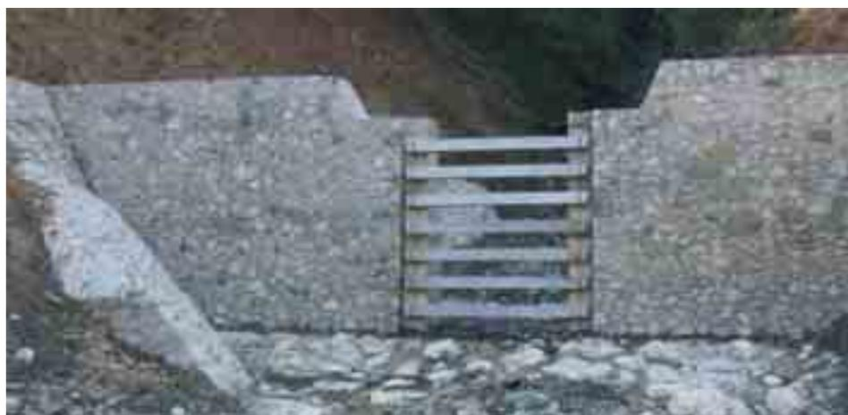
**Figura 5.1.8:** Briglia a fessura rettangolare con barre trasversali in profilato di acciaio smontabili da valle per permettere l'asporto del materiale solido in accumulo.
