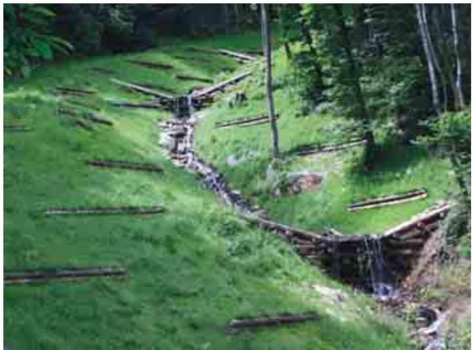
**Figura 6.4.33:** Nello schema è rappresentata una combinazione di biorete in cocco con fascinate vive. La fascinata oltre a consentire la messa a dimora di specie arbustive, garantisce anche una protezione meccanica leggera.
