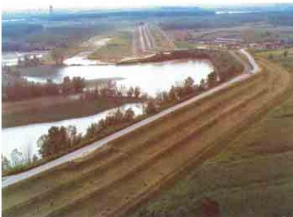
Figura 2.0.1: Argine del Po con banca, sottobanca e piè di banca
