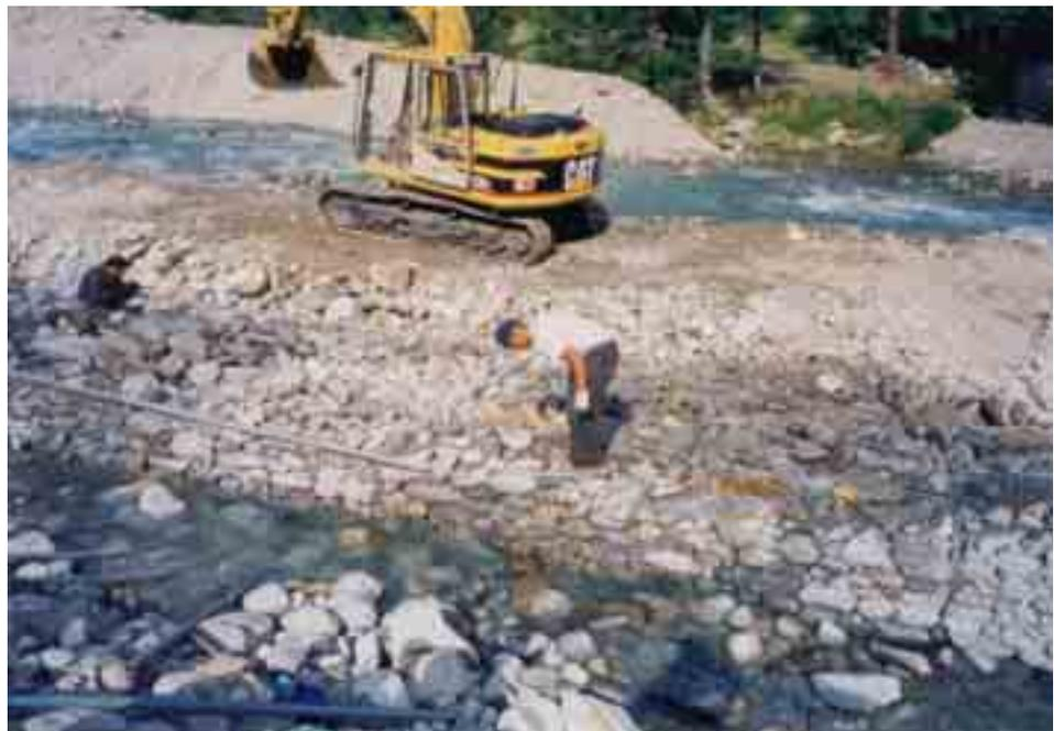
Le gabbionate sono delle strutture permeabili, resistenti ed allo stesso tempo molto flessibili in grado di sopportare senza gravi deformazioni dei singoli elementi, assestamenti e/o cedimenti del piano di posa o del terreno a tergo dovuti.
