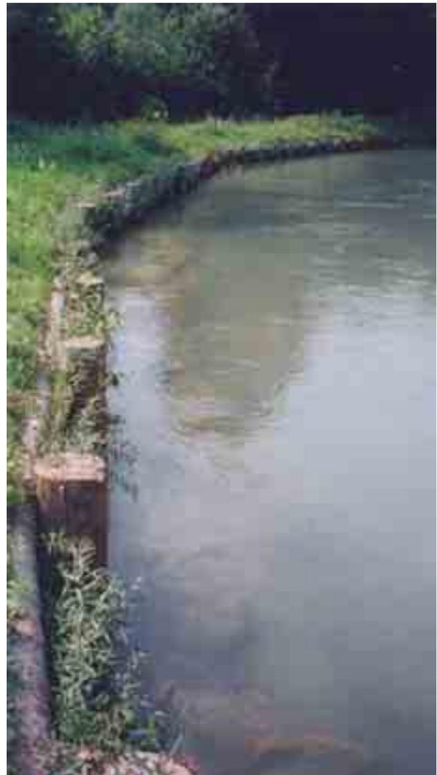
**Figura 6.5.6:** I salici della palificata hanno attecchito, nel giro di pochi mesi la sponda sarà rivegetata e si creeranno condizioni favorevoli per l'insediamento della fauna sia acquatica che terrestre.
