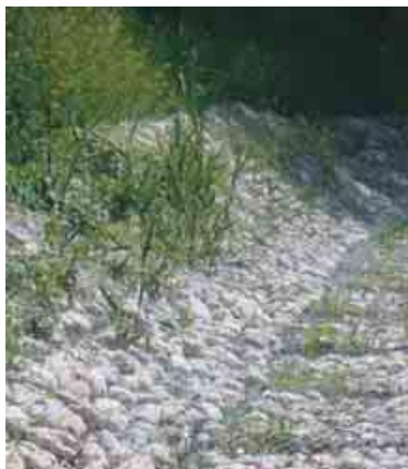
Generalmente, se le condizioni idrauliche lo consentono, vengono messe a dimora anche talee per realizzare, in tempi più lunghi, una copertura arbustiva dotata di maggiore capacità di protezione meccanica e di più elevato valore ambientale.
