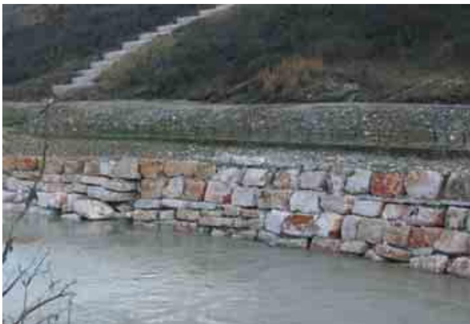
**Figura 6.3.6:** La costruzione di una muratura a secco, oltre all'aspetto funzionale può avere una valenza estetica.
