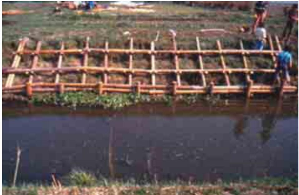
**Figura 6.4.41:** Le talee di salice o di tamericio, sono un elemento costruttivo essenziale della grata viva. Le forti pendenze su cui generalmente si costruiscono tali strutture ed il degrado cui è soggetto il legname, richiedono un consolidamento efficace e di lungo termine. Una volta sviluppatesi le piante, le radici consolideranno il terreno e le parti aeree assorbiranno buona parte dell'energia dell'acqua in occasione di eventi di piena. (Canale c/o Rovigo, loc. Loreo)
