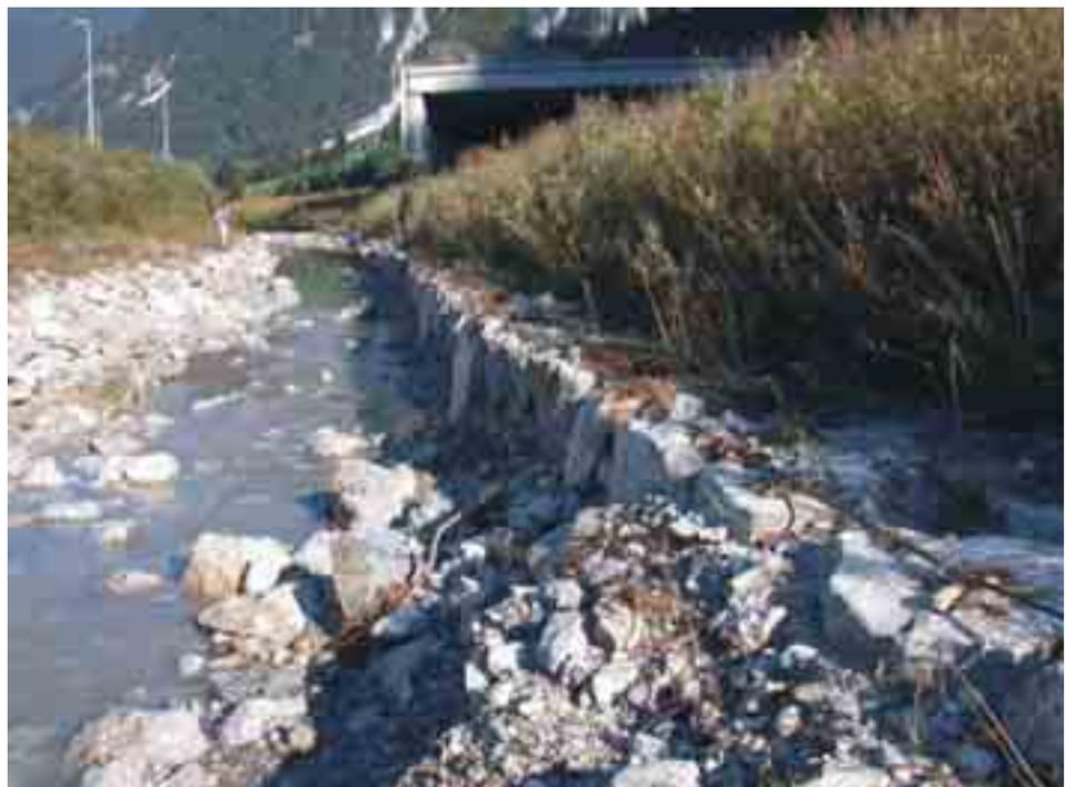
Quando la protezione con scogliere o gettate riguarda una parte a fiume, senza interessare cioè l'arginatura maestra, nella sezione iniziale del rivestimento è necessario immergere adeguatamente il rivestimento stesso nell'ammasso protetto per evitare che possa prodursi un aggiramento della testa. Per rivestimenti di sponda estesi in senso longitudinale, è importante provvedere anche a immorsamenti intermedi.
