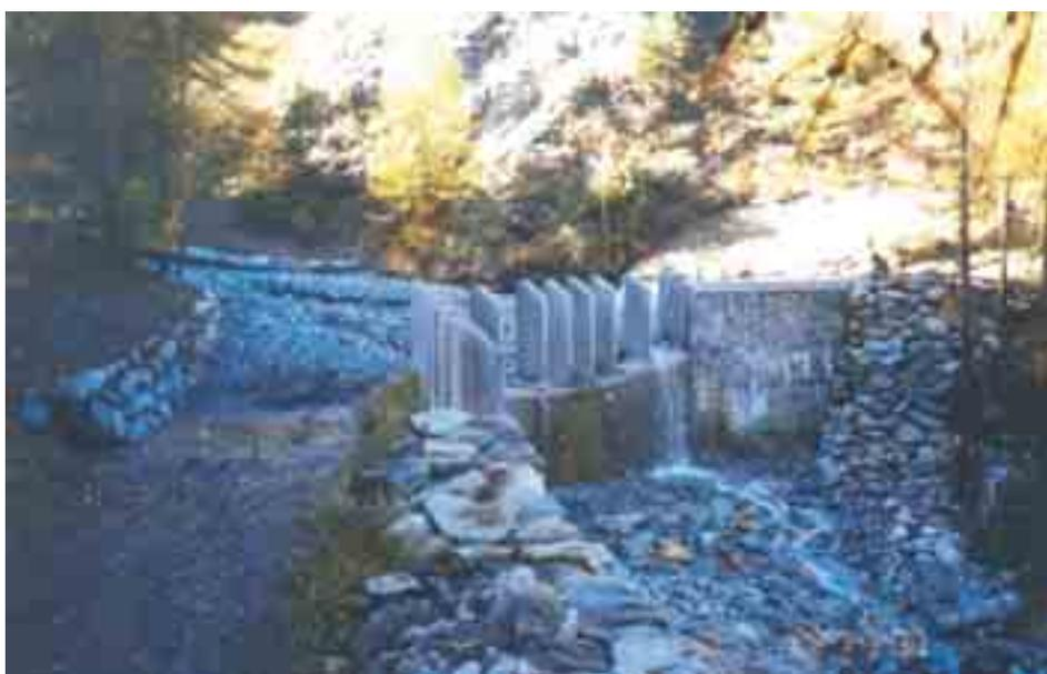
Qualunque sia la tipologia di queste strutture, si tratta di opere caratterizzate da una estrema robustezza ottenuta facendo uso di cemento armato e protezioni in acciaio nei punti esposti all'impatto. Un'attenzione particolare va dedicata anche alle fondazioni, in quanto le sollecitazioni a cui sono soggette sono molto elevate; per impedire che vengano trascinate via dalla massa impattante, spesso è necessario ancorarle con elementi strutturali operanti in trazione.
