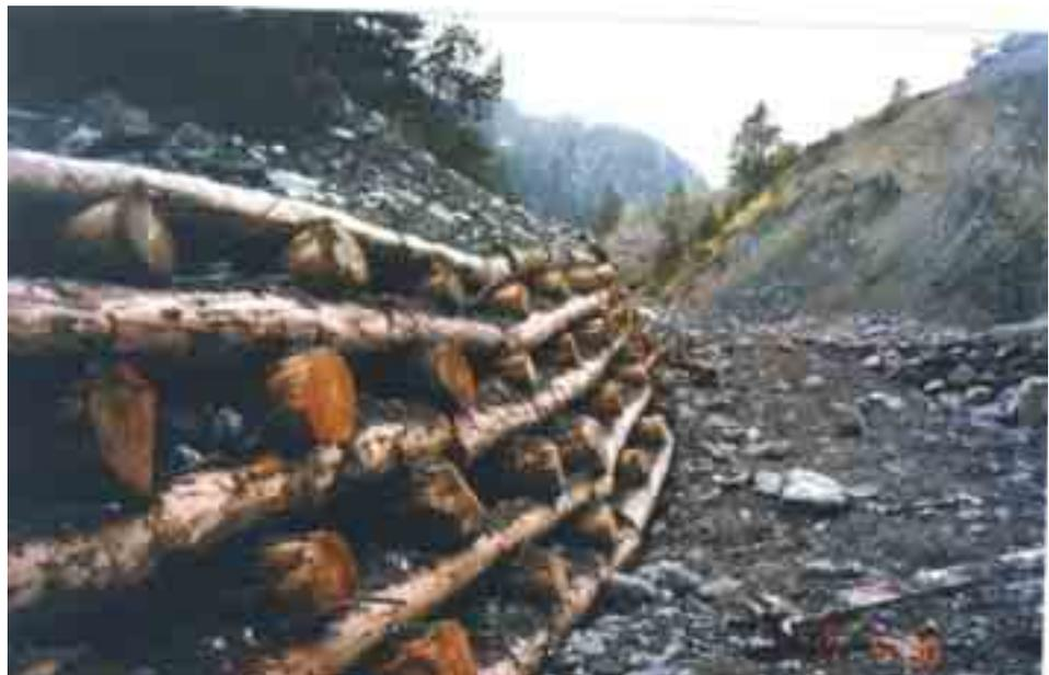
**Figura 6.3.34:** La scogliera posta al piede della palificata ed i blocchi in fondazione hanno la funzione di proteggerla dall'azione del trasporto solido più grossolano e dallo scalzamento dovuto all'erosione.
