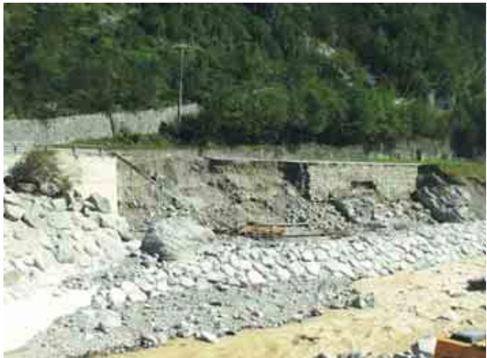
Il pericolo di erosione e di scalzamento può essere contrastato anche con protezioni al piede mediante un taglione o con colonne accostate di jet-grouting.
