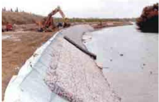
**Figura 6.4.5:** Posa di materassi in rete metallica a doppia torsione riempiti di pietrame. Ad ulteriore protezione del terreno della sponda è stato posto un filtro in geotessile non tessuto. Si osservi la chiusura dei materassi che viene effettuata con un unico telo di rete metallica a doppia torsione.
