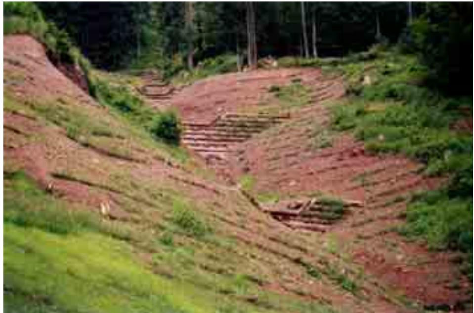
**Figura 6.1.18:** Particolare della gaveta rivestita con tondame di legno.
