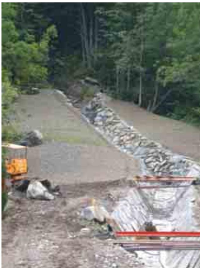
L'utilizzo di questo tipo di opera è controindicato in abbinamento con la vegetazione, in quanto è necessario mantenere basse le scabrezze, cosa resa difficile dalla presenza di piante.
