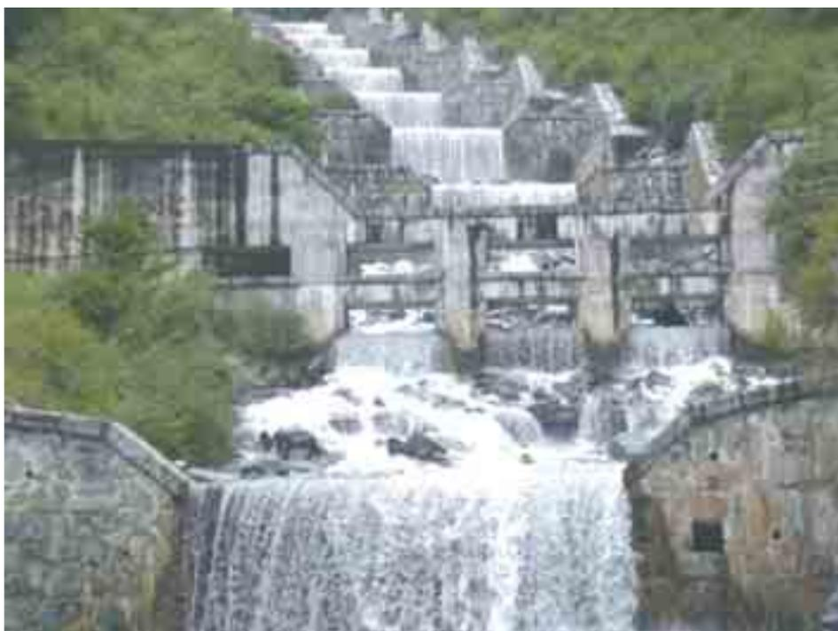
**Figura 6.1.2:** Sistemazione a gradinata con briglie in cemento armato, realizzata sull'accumulo detritico della frana della "Val Pola" in Valtellina (SO).
