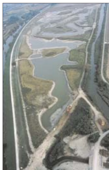
Fig. 6.3: l'area dopo l'intervento
