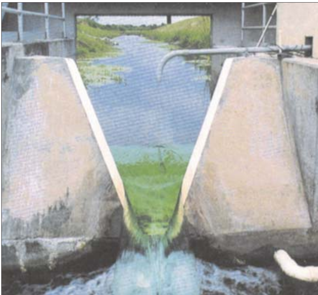
Esempio di struttura d'outlet con stramazzo a V per la misurazione della portata.
