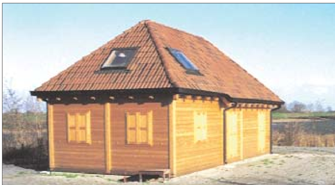
Fig. 6.6: edificio ospitante laboratorio e sala d'accoglienza per i visitatori
