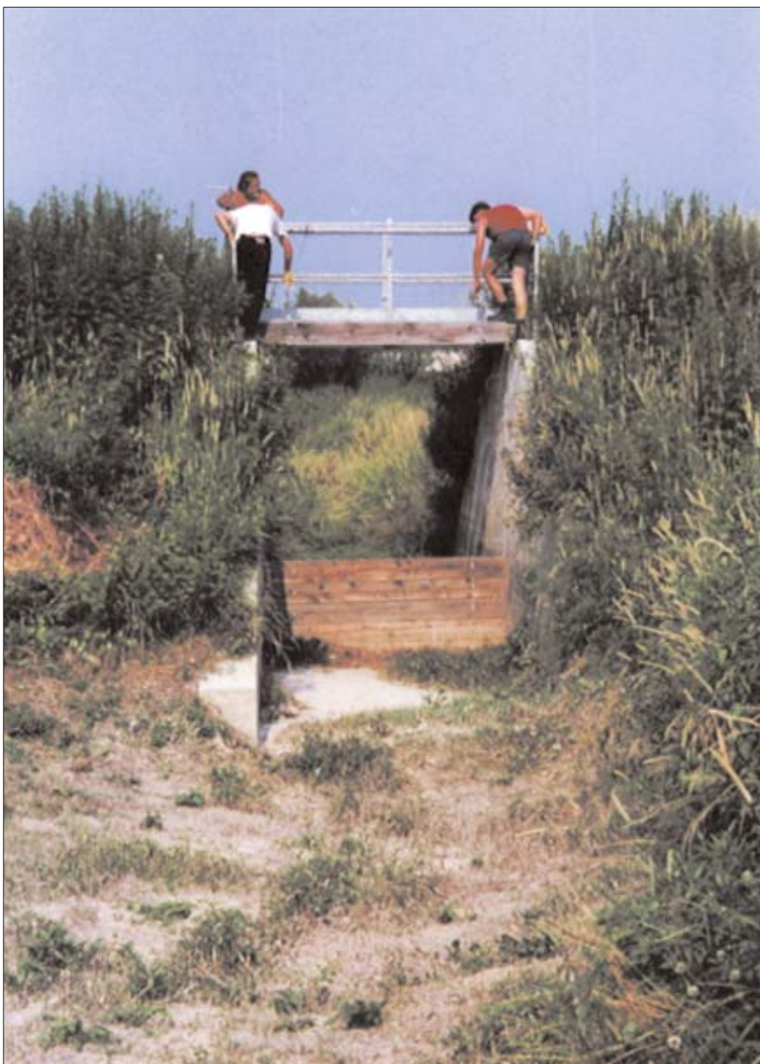
Panconature in legno. Si suggerisce ove possibile l'uso del legno per i particolari costruttivi, perché nell'area umida genera un minore impatto visivo rispetto agli altri materiali.
