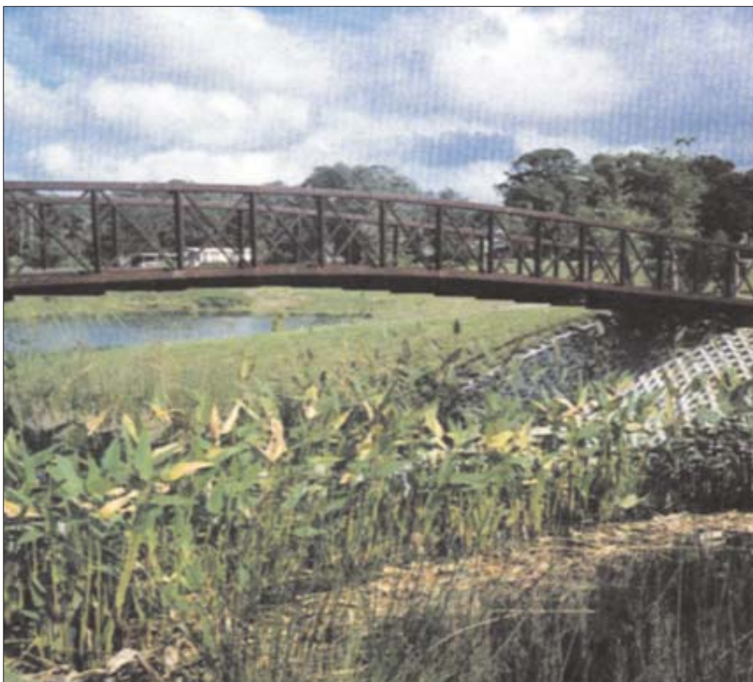
Ponte in legno per favorire la fruibilità didattico/ambientale dell'area umida.
