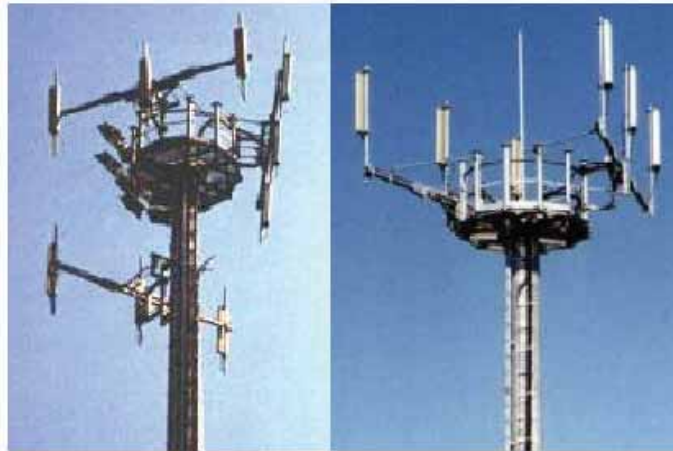
Figura III-15 Stazioni radiobase di tipo settoriale
