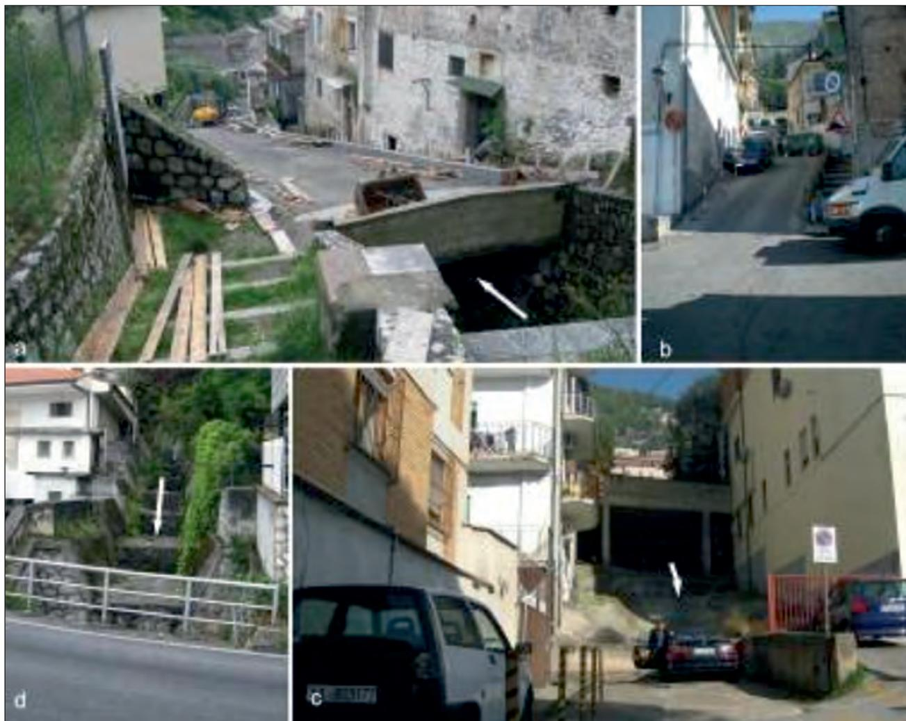
Fig. 1 - Esempi dello stato degli alvei nel Comune di Sala Consilina. In (a) e (b) l'impluvio principale è tombato; (c) l'impluvio diventa un alveo strada; (d) l'alveo presenta una sezione molto piccola ed è delimitato lateralmente da abitazioni.
