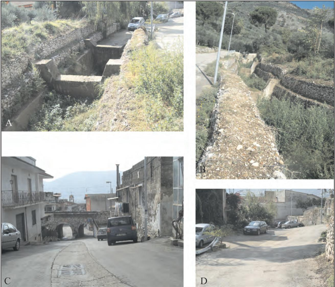
Fig. 11 - Carta delle condizioni idrauliche. A e B alveo sistemato con briglie, C e D alveo tombato/strada.
