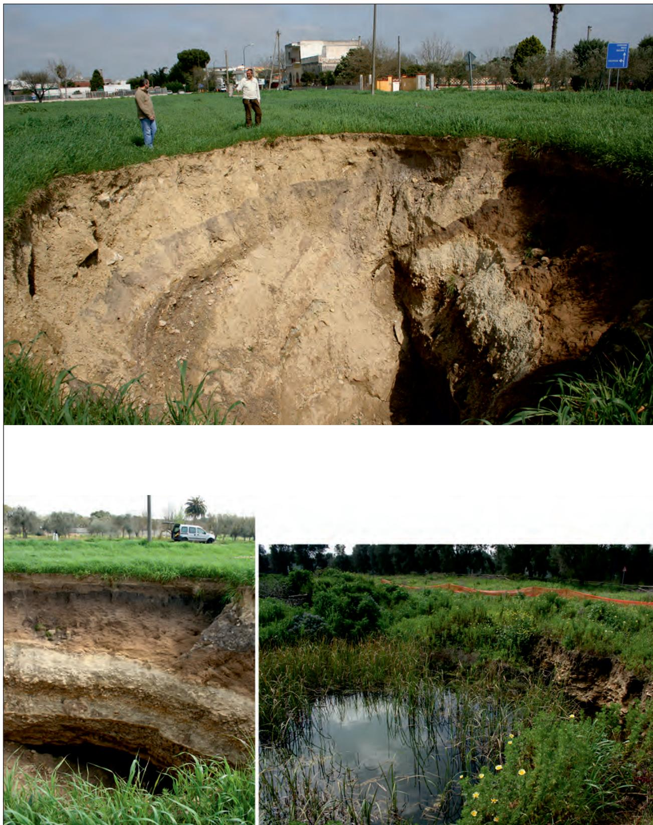
Fig. 10 - Eventi di sprofondamento a Cutrofiano connessi alla presenza di cave sotterranee di calcarenite: a sinistra e in alto, lo sprofondamento del Maggio 2010 (evento n. 58 in tabella 1); da notare la prossimità dello sprofondamento alla Strada Provinciale. A destra, un antico sprofondamento attualmente con presenza di acqua.
