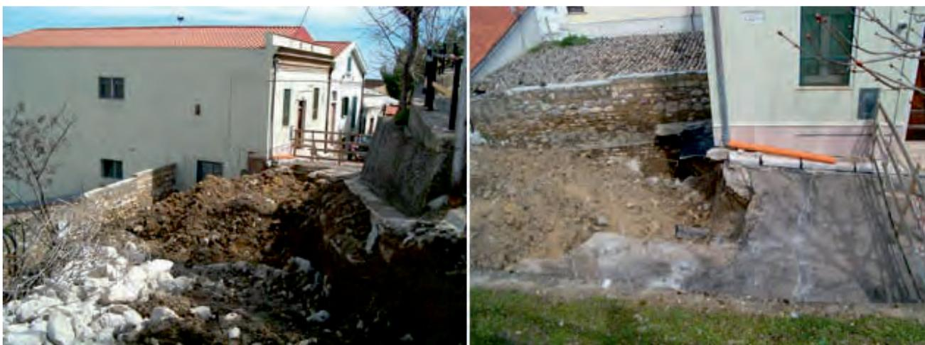
Fig. 5 - Vista complessiva (a sinistra) e particolare (a destra) dello sprofondamento avvenuto a Candela nell'aprile 2006 (evento n. 40 in tabella 1), a causa del crollo della volta di una cantina-deposito.
