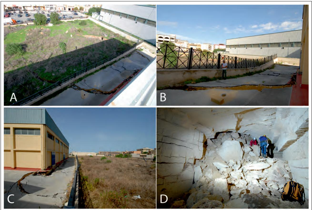
Fig. 6 - A - Sinkhole creatosi nel giugno 2011. B e C - Danni provocati dallo sprofondamento ai manufatti sovrastanti. D - Materiale di crollo presente all'interno della cava in prossimità dell'area interessata dal sinkhole.
