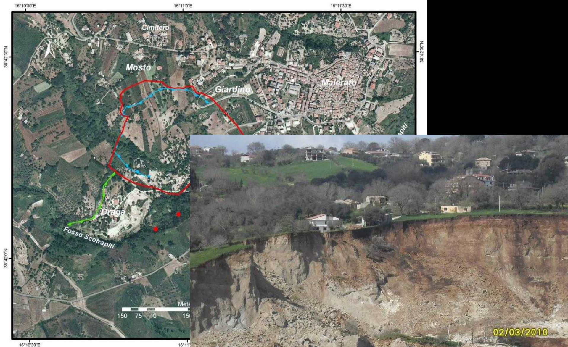
La notte tra 20 e 21 febbraio la frana si è riattivata, determinando un arretramento della scarpata di circa 80 m nella parte centrale della corona principale, con la formazione di una nicchia di distacco larga circa 200 m. Il nuovo volume di materiale franato è stimabile in circa 400.000 metri cubi.
