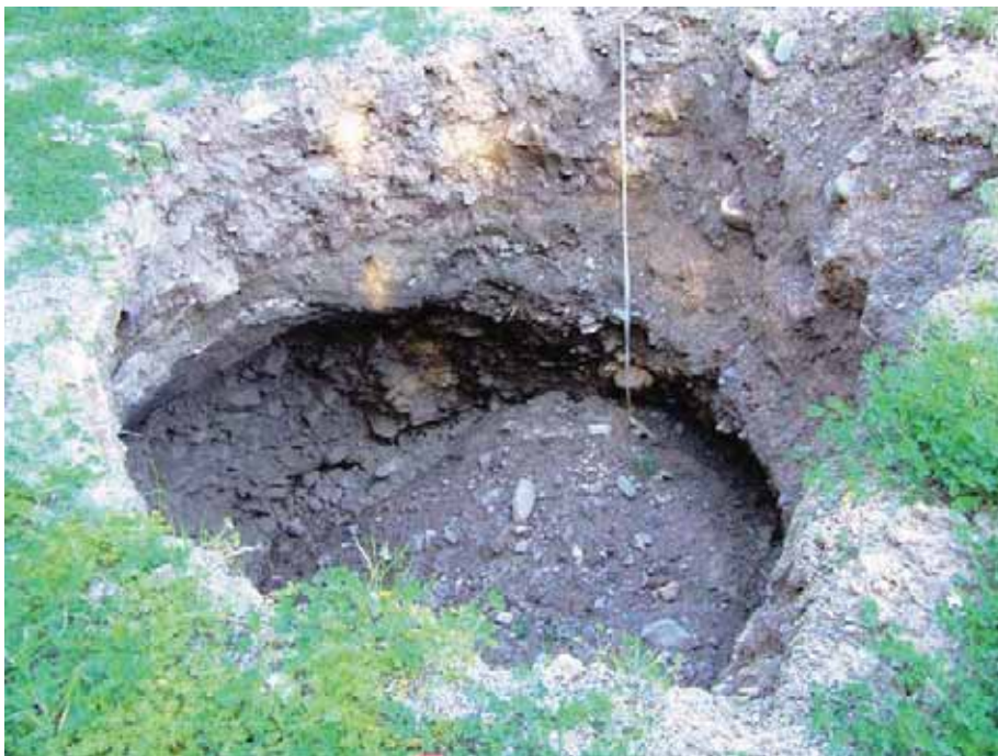
Fig. 9 - Esempio di un piccolo sinkhole (scavernamento) presso l'area di Narcao.
