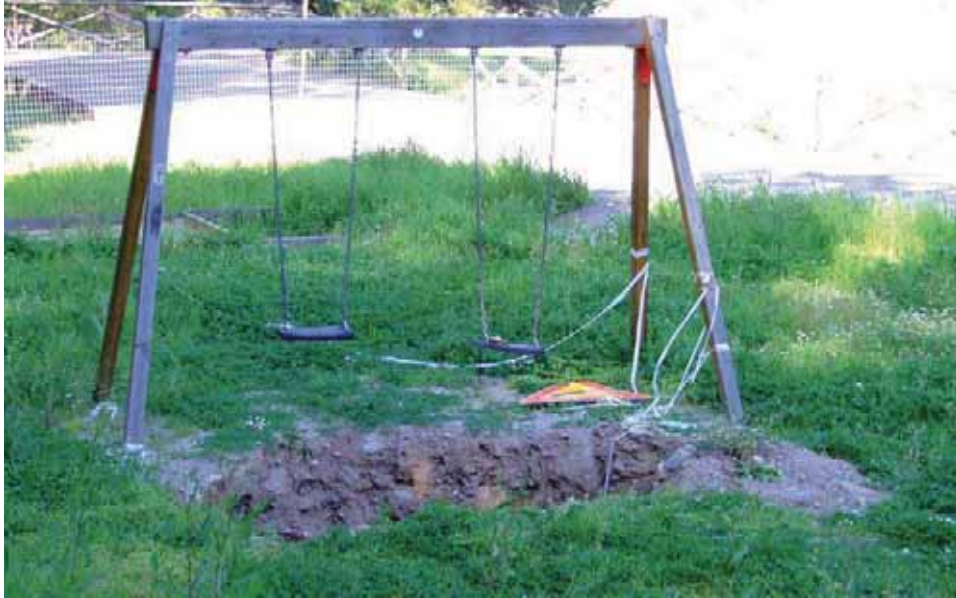
Fig. 8 - Un sinkhole presso il centro abitato (giardini pubblici) di Narcao
