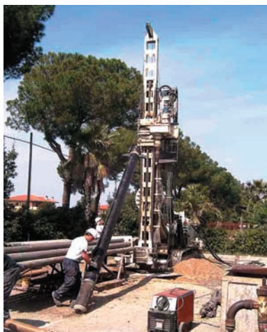
Fig. 1 - Cantiere Tor Tre Ponti in esecuzione
