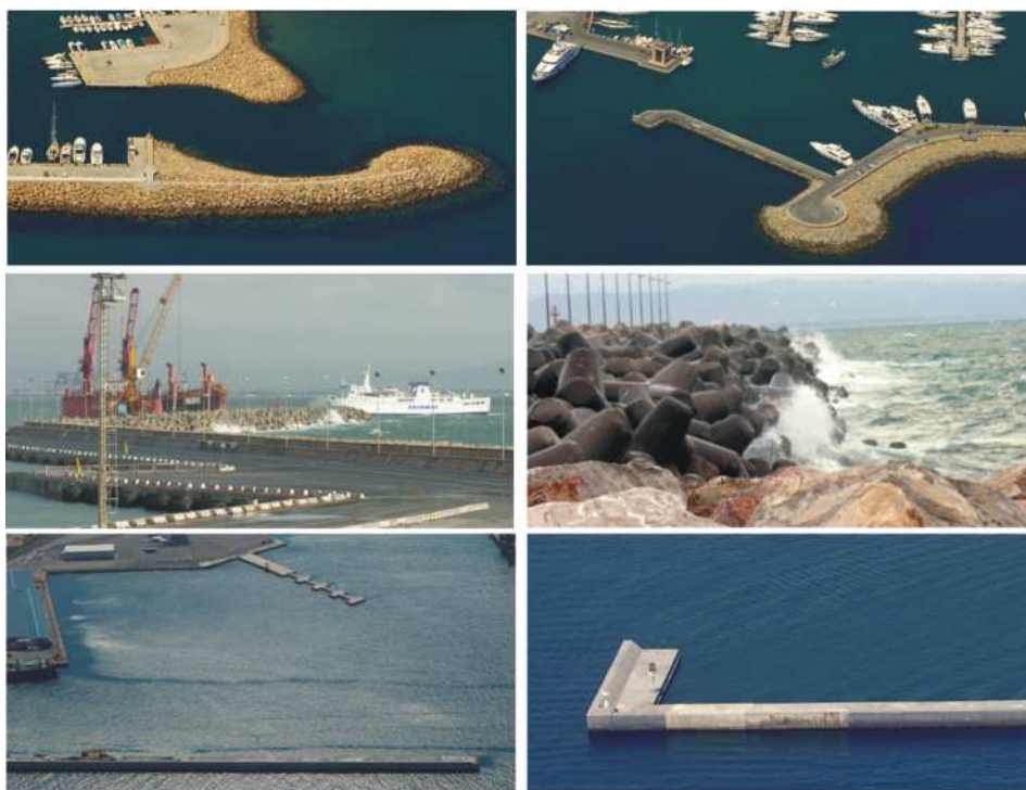
Figura 7.1.2: Differenti tipologie di diga marittima. In alto, dighe a scogliera in massi naturali: porto di Andora (SV), a sinistra; porto di Sanremo (IM), a destra. Al centro, porto di Piombino (LI), diga a scogliera in massi tetrapodi (a sinistra); particolare della diga (a destra). In basso, dighe a parete verticale: a sinistra, porto di Vado Ligure (SV); a destra, particolare della testata della diga foranea del porto di Genova.
