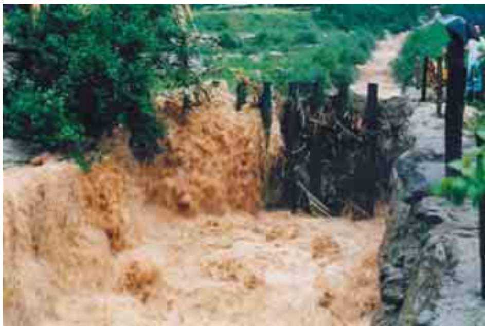
Figura 5.1.10: La foto mostra il comportamento di una piccola briglia a pettine in occasione di una piena. Il materiale legnoso si accumula a ridosso delle putrelle e l'acqua passa oltre. Se la briglia però viene completamente occlusa l'acqua è costretta ad aggirare l'opera con il rischio di scalzamento o di esondazione. Quando è possibile, in opere di piccole dimensioni, si può intervenire ad asportare il legname per mezzo di escavatori operando dall'alto.
