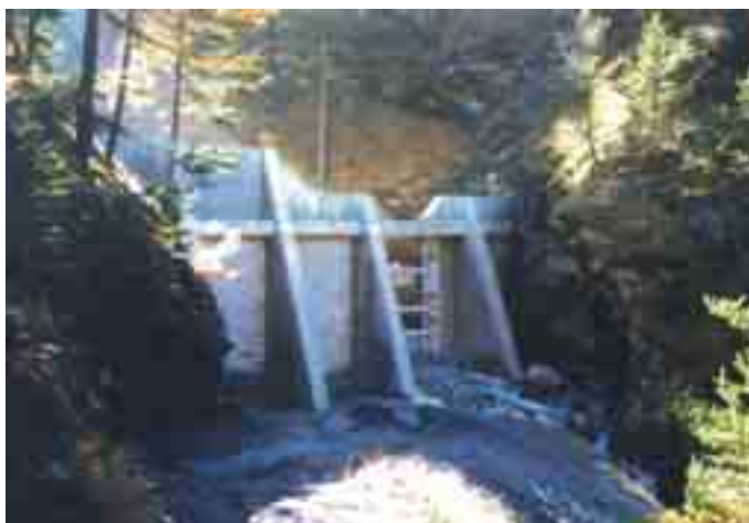
Figura 5.1.6: Briglia a fessura con contrafforti e traverse. La fessura è dotata di tubolari amovibili di sbarramento e la sua larghezza è definita in modo da permettere l'accesso a mezzi meccanici per lo sgombero dei materiali eventualmente accumulati a tergo (Rio Champeyron, Comune di Oulx, TO).
