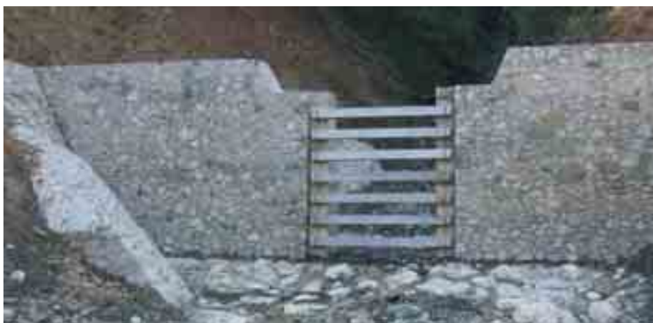
Figura 5.1.6: Briglia a fessura con contrafforti e traverse. La fessura è dotata di tubolari amovibili di sbarramento e la sua larghezza è definita in modo da permettere l'accesso a mezzi meccanici per lo sgombero dei materiali eventualmente accumulati a tergo (Rio Champeyron, Comune di Oulx, TO).
