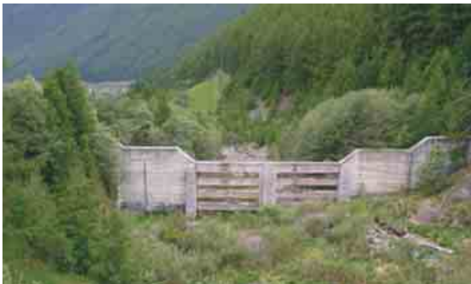
Figura 5.1.4: Esempio di briglia aperta a finestre orizzontali, adatta a trattenere anche materiale di medie dimensioni.
