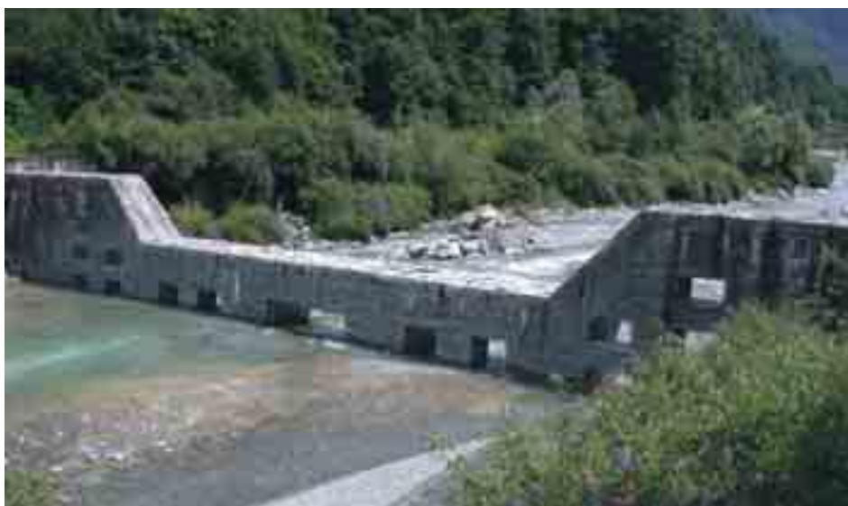
Figura 5.1.5: Briglia aperta a finestre. Il volume disponibile a tergo dell'opera per il trattenimento del trasporto solido è parzialmente riempito e richiederebbe un intervento di manutenzione per ripristinare completamente la funzionalità della briglia. (Valmalenco, SO)
