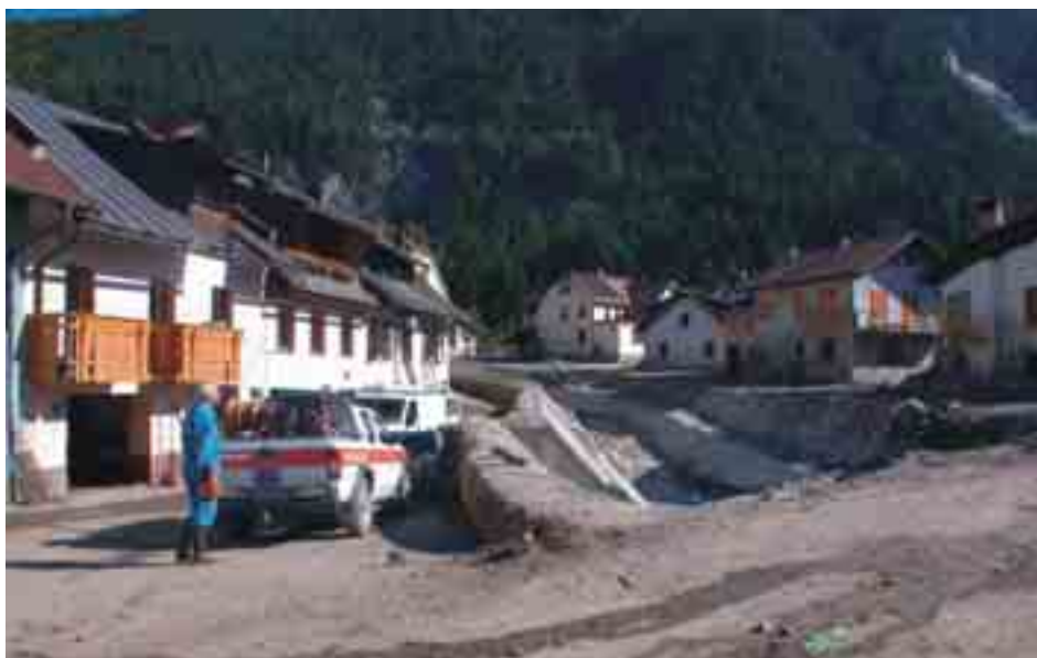
Figura 5.3.4: Cunettone a sezione trapezia, rivestito in pietrame. Il torrente, che in questo tratto passa all'interno di un abitato, è costretto ad una brusca variazione di direzione e subisce una riduzione di sezione in corrispondenza del ponticello che si vede nella foto successiva. In occasione dell'evento alluvionale verificatosi in Friuli nel settembre 2003, l'eccesso di portata e il transito di colate detritiche hanno causato l'esondazione in questo punto critico. Nella foto successiva è mostrato il ponte con i segni dei danni prodotti dai detriti che lo hanno investito.
