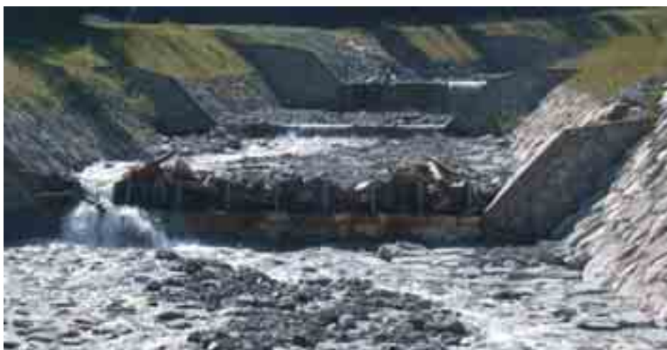
Figura 5.1.3: Briglia a pettine occlusa dal materiale trasportato.
