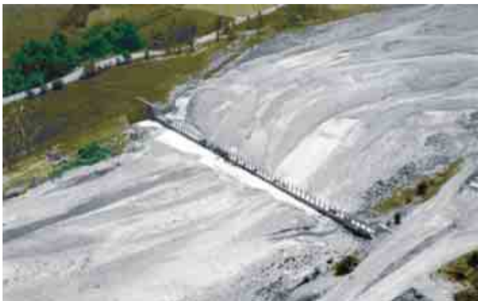
Figura 5.1.11: Le briglie a pettine sono impiegate soprattutto nei torrenti, dove il trasporto solido flottante può essere abbondante a causa delle caratteristiche dei bacini montani. In certe situazioni però le briglie a pettine possono venire impiegate anche nei grandi fiumi di pianura. E' questo il caso in cui sia necessario proteggere delle opere quali ad esempio le casse di espansione o i ponti. (Briglia a monte di una cassa di espansione lungo il Secchia)
