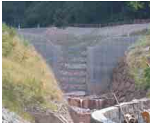
Figura 5.1.7: Briglia a fessura. La fessura è stata dotata di profilati d'acciaio che non fanno filtrare neanche il materiale di dimensioni medio piccole. Si osserva il rivestimento con scogliera del tratto d'alveo immediatamente a valle della briglia, per evitare l'erosione della corrente.
