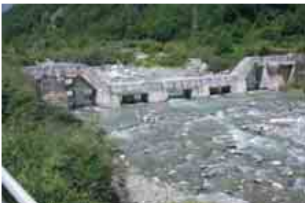
Figura 5.0.3: Briglia di trattenuta a finestre. La struttura massiccia e di grandi dimensioni è stata quasi completamente riempita a tergo dai sedimenti depositi dalla corrente. E' necessario procedere alla manutenzione per ripristinare a pieno la funzionalità dell'opera.
