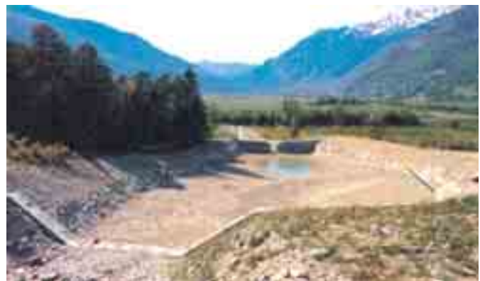
Figura 5.0.4: Piazza di deposito con briglia a fessura per il trattenimento dei sedimenti. L'opera deve essere abbastanza grande da contenere i sedimenti che possono deporsi almeno nell'arco di un evento importante. Per mantenerne la funzionalità sono molto importanti le manutenzioni periodiche e successivamente ad eventi estremi.
