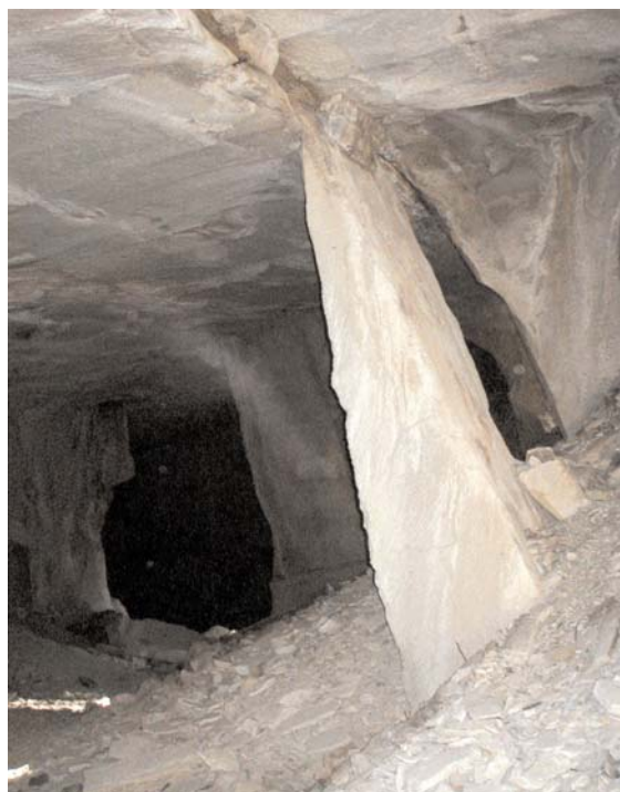
Fig. 6d - Interno della cava Canara (cava tipo latomia); in primo piano un “piede” che sostiene il “cielo” in corrispondenza di una frattura.
