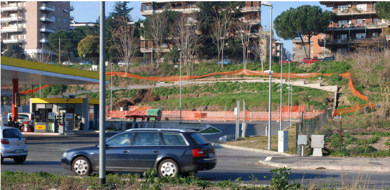
Fig. 10 - Frana di via Alberese (F229). Dietro il distributore di benzina posto sulla via Isacco Newton, al Portuense, si nota il muro di sostegno costruito a seguito del franamento occorso in occasione dello sbancamento per l'apertura della piazzola. La frana ha interessato il versante fino alla sua sommità, danneggiando la soprastante via Alberese. - Via Alberese Landslide (F229). Behind the Via Isacco Newton gas station it is possible to see a concrete wall built after the occurrence of a landslide originated by the digging works. The slide damaged also the road (Via Alberese) on the top of the slope.
