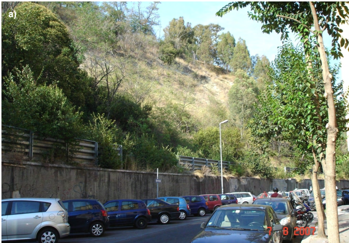
Fig. 37 - Scorcio del versante prospiciente Via A. Labriola (a) e particolari del muro di contenimento (b) e (c) alla base del versante con evidenti cenni di lesioni dovute alla spinta del corpo di frana retrostante. - A view of the Via A. Labriola slope (a), and enlargements of the retaining wall (b) and (c) showing some cracks, due to the downslope movement of the terrain behind it.
