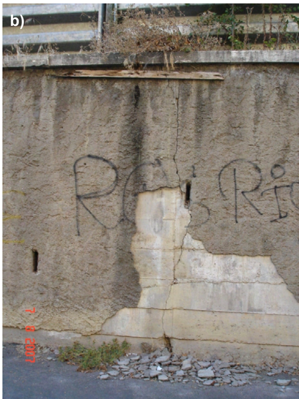
Fig. 37 - Scorcio del versante prospiciente Via A. Labriola (a) e particolari del muro di contenimento (b) e (c) alla base del versante con evidenti cenni di lesioni dovute alla spinta del corpo di frana retrostante. - A view of the Via A. Labriola slope (a), and enlargements of the retaining wall (b) and (c) showing some cracks, due to the downslope movement of the terrain behind it.
