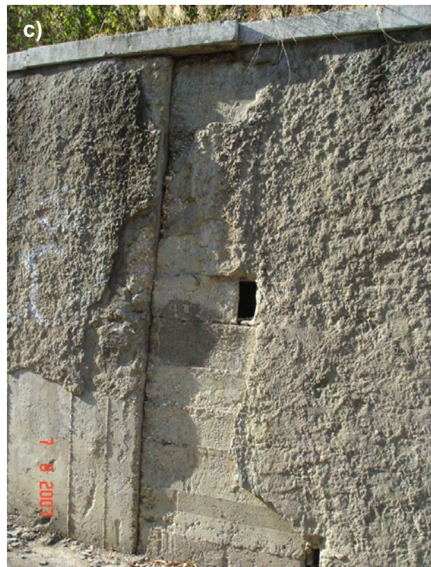
Fig. 37 - Scorcio del versante prospiciente Via A. Labriola (a) e particolari del muro di contenimento (b) e (c) alla base del versante con evidenti cenni di lesioni dovute alla spinta del corpo di frana retrostante. - A view of the Via A. Labriola slope (a), and enlargements of the retaining wall (b) and (c) showing some cracks, due to the downslope movement of the terrain behind it.
