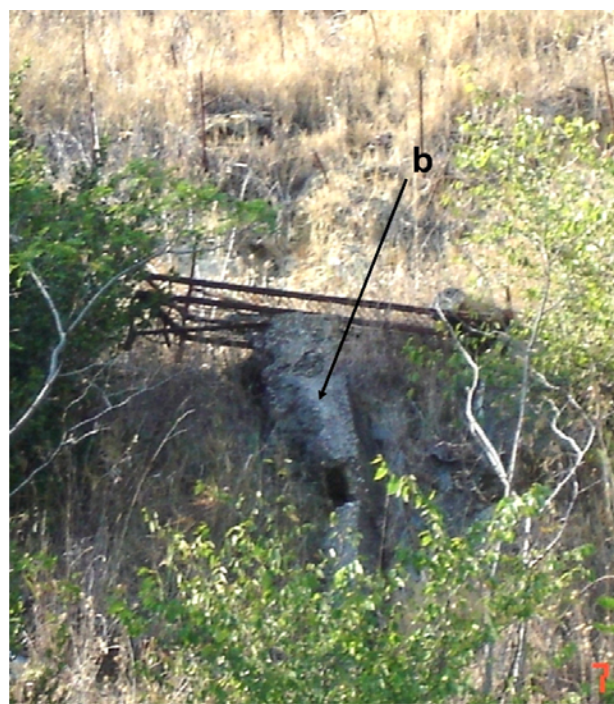
Fig. 38 - Particolari delle strutture in cemento armato realizzate per la bonifica del versante dopo l'evento del 1960. a) uno dei muretti di contenimento a sviluppo parallelo al versante; b) e c) elementi delle canalizzazioni per il drenaggio delle acque superficiali disarticolati dai processi di instabilità del versante.
