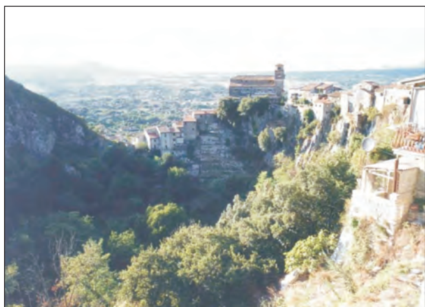
Fig. 135 - Dolina di crollo nell'abitato di Artena; località La Prece fuori le Porte. - Collapse doline in the Artena village; La Prece, fuori le Porte locality.
