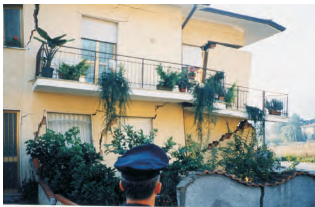
Fig. 54 - Particolare, prima e dopo l'evento, del fabbricato crollato. - The damages of the sinkhole disaster.
