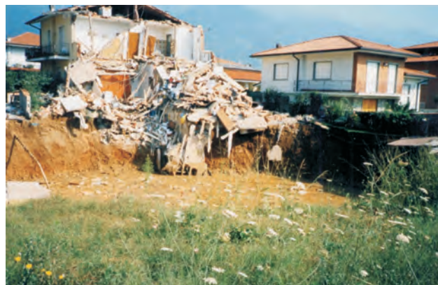
Fig. 54 - Particolare, prima e dopo l'evento, del fabbricato crollato. - The damages of the sinkhole disaster.
