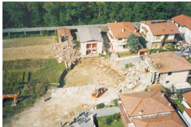
Fig. 55 - Operazioni di colmamento della "voragine". - Filling of the sinkhole.
