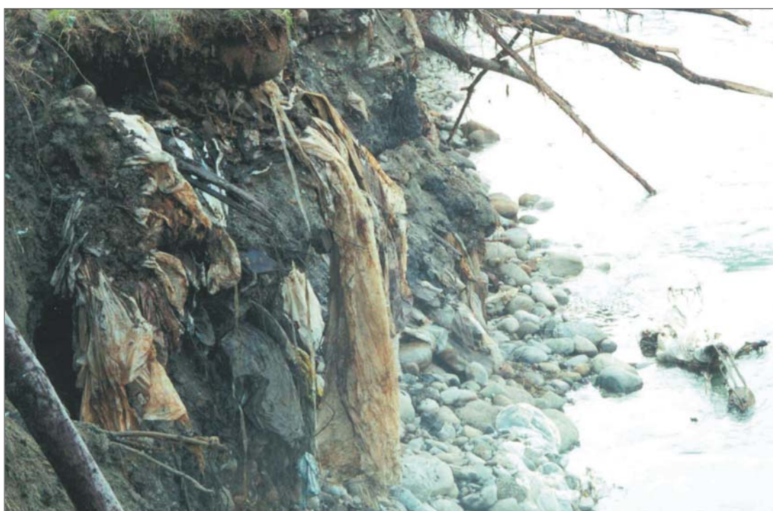
Foto 1-4: Particolare del fronte della discarica esposto dall'erosione di sponda del T. Orco. In primo piano sono visibili i rifiuti rappresentati da scarti di pellame, fanghi disidratati ed altri di tipo speciale o assimilabili a RSU.
