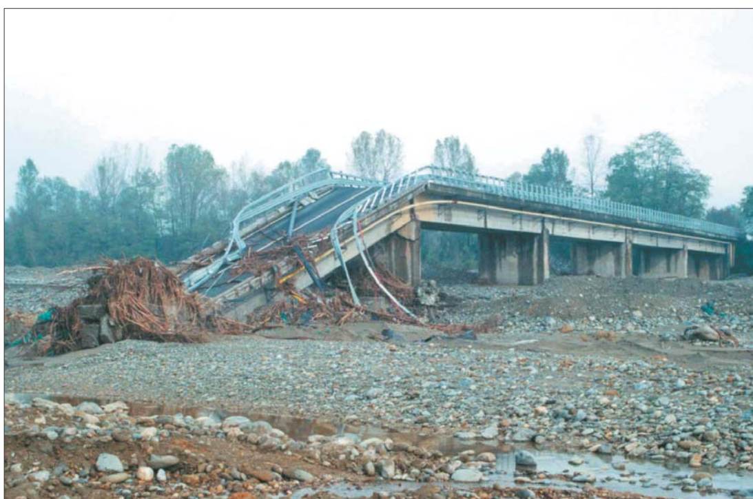
Foto 2-2: Asportazione di parte del ponte situato 250 metri a monte dello stabilimento dell'Agip Petroli. La strada interrotta è quella che collega i comuni di Robassomero e Ciriè.
