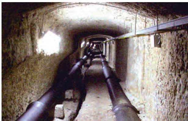
Fig. 22 – Galleria dell'acquedotto sotterraneo di Cagliari. – Cagliari's aqueduct tunnel.
