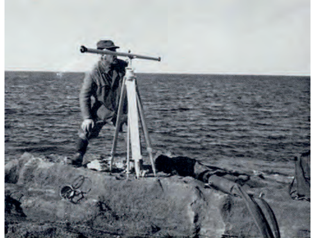
Fig. 34 – Una delle stazioni di posizionamento nave da terra col metodo della triangolazione con teodolite.
