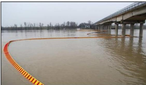
*Figura 2. Barriere di contenimento (semi-rigide)*
