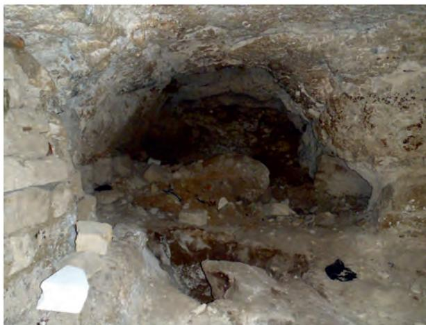
Fig. 5 - Dissesto all'interno di una cavità artificiale nel centro storico di Ginosa.
