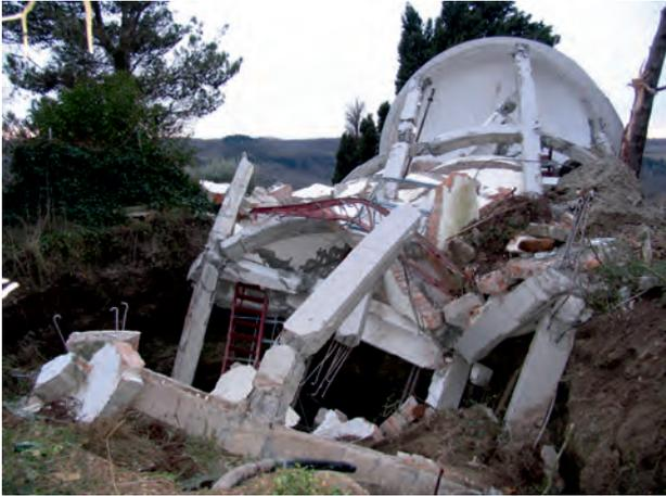
Fig. 10 - Esempio di dissesto per interferenza fra ipogei e strutture in superficie.
