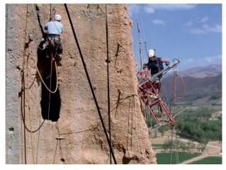
Fig. 10 – Consolidation works in the Bamiyan cliff. – Lavori di consolidamento sulla parete di Bamiyan.
