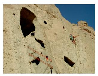
Fig. 9 – Consolidation works on the Bamiyan niche. – Lavori di consolidamento nelle nicchie di Bamiyan.
