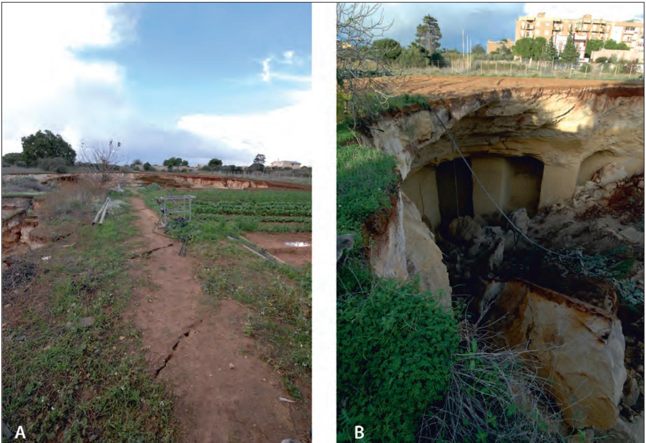
Fig. 4 - A: Fratture parallele al perimetro dello sprofondamento, legate al rilascio tensionale successivo alla sua formazione. B: Particolare del settore NO dello sprofondamento con visibili i vani ipogei e l'allargamento dei vuoti, in corrispondenza della porzione più grossolana del corpo calcarenitico.
