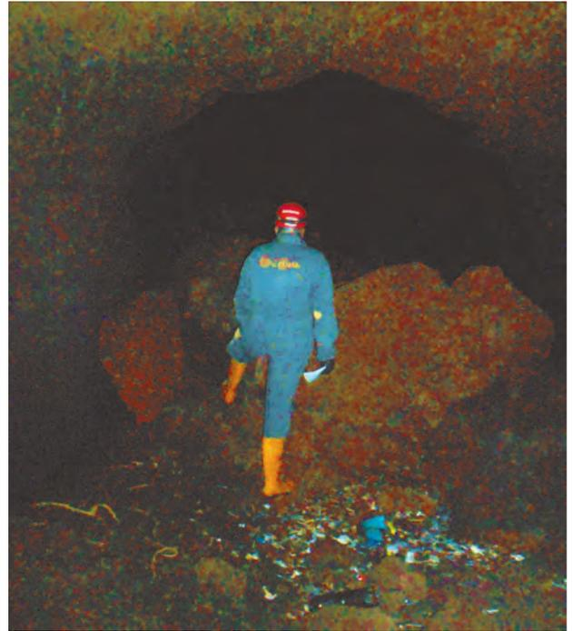
Fig. 15 – Eventi di crollo presso i sotterranei di Via Columella, Quadraro.
