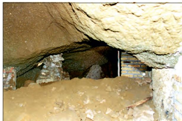
Fig. 13 - Diramazione verso nord dal picchetto 0/3 all'interno di un ambiente con materiale dovuto a crollo. A destra un pilastro in mattoni.
