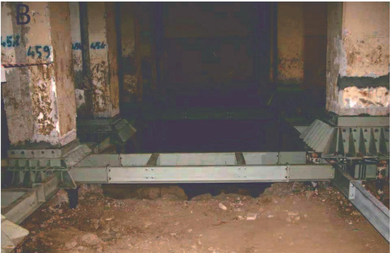
Fig. 33 - (A) Veduta della rimozione del piano di calpestio propedeutica allo scavo per il ritrovamento delle mura nel sottosuolo del primo piano dell'ex Regio Ufficio Geologico. (B) Scavo per l'indagine sulle strutture murarie.
