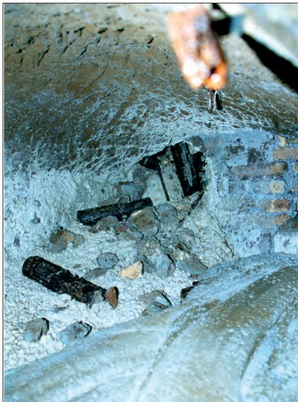
Fig. 21 - Pezzi di tubo di ferro nel calcestruzzo.
