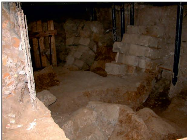
Fig. 35 - I due accumuli di conci di tufo nello scavo dell'ex Regio Ufficio Geologico indicano che un piccolo tratto di mura ha subito un modesto dissesto localizzato. I tubi neri sono micropali.
