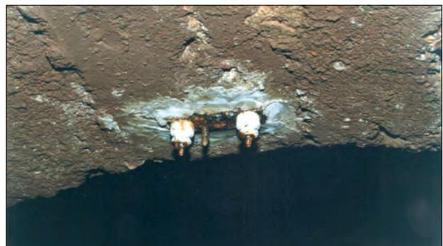
Fig. 10 - Particolare degli isolatori sul portale ad arco.
