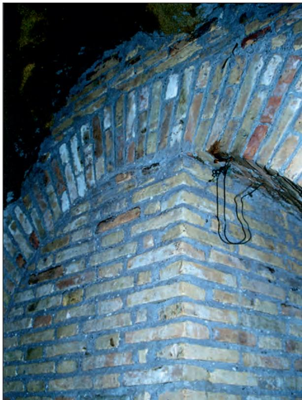
Fig. 20 - Pilastro in mattoni di rinforzo della calotta sovrastante.
