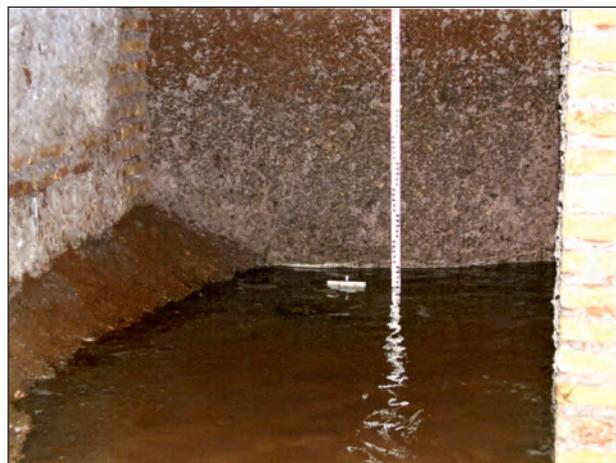
Fig. 25 - Pilastro in mattoni nel corridoio tra i picchetti 1/3 e 1/4 nel quale è presente acqua durante il terzo sopralluogo (14 gennaio 2002).
