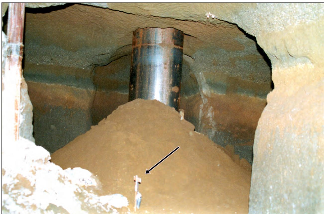
Fig. 7 - Tubazione di accesso alle gallerie. In primo piano il cono del materiale di risulta dallo scavo, il picchetto 1/1 evidenziato dalla freccia e la nicchia orientata verso ovest.
