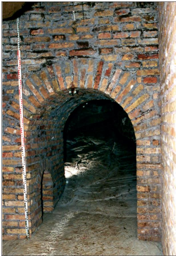
Fig. 19 - Pilastro in mattoni di rinforzo della calotta sovrastante.
