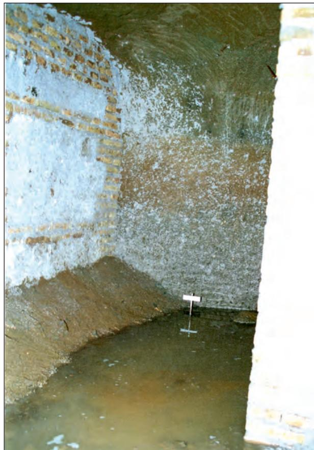
Fig. 24 - Livello dell'acqua durante il terzo sopralluogo (14 gennaio 2002) al picchetto 1/3.
