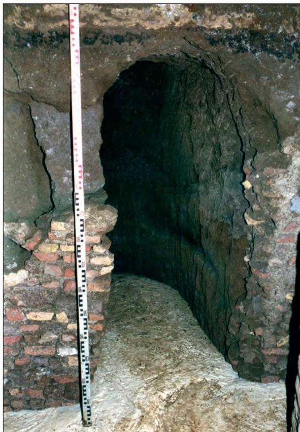
Fig. 17 - Ultimo tratto verso il picchetto 0/9. Si notano la colata di cemento in primo piano, il muro in pietra a sinistra e il rinforzo in pietra sulla destra.
