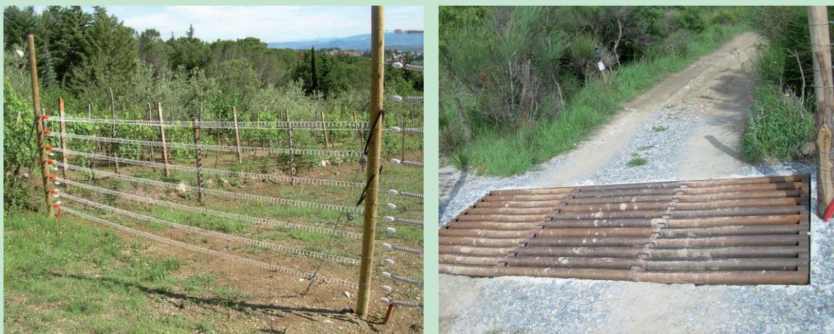
Figura C e D - Cannello elettrificato e griglia dissuasiva al passaggio dei selvatici. Foto S. Innocenti.
