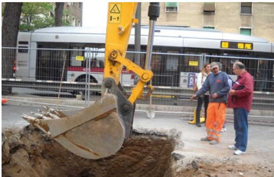
Il 19 ottobre 2011, in via Sebino (Municipio II), si è verificato, al centro della carreggiata, all'incrocio con piazza Verbano, un ulteriore episodio di sprofondamento, questa volta di piccolo diametro, ma di elevata profondità (del diametro di 70 centimetri e profonda una ventina di metri), dovuto allo sbocco in superficie di un pozzetto di collegamento con la sottostante rete idrica.
