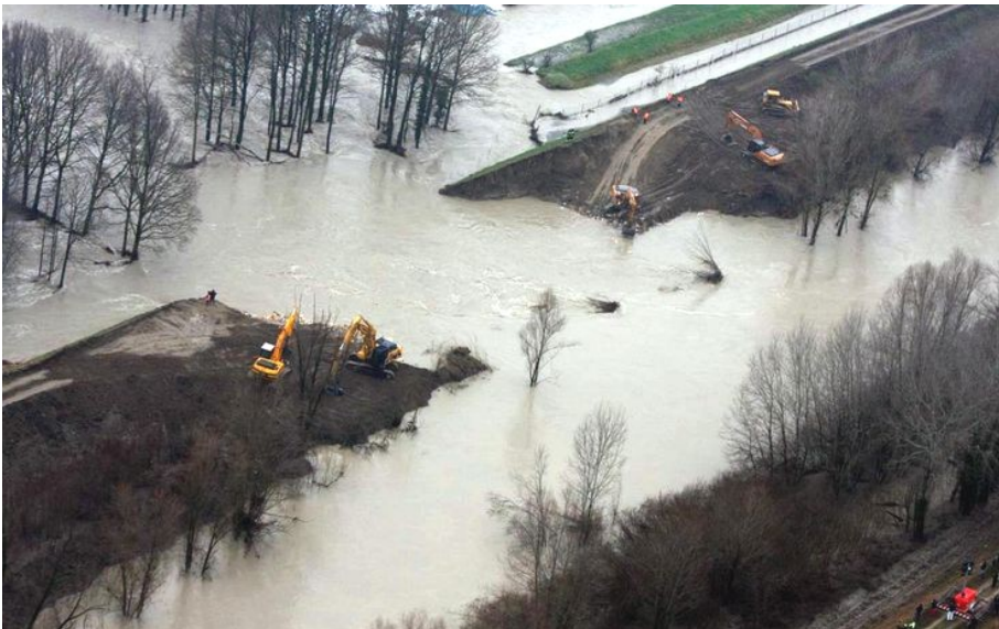
Foto 2.3.11 – Lavori di ricostruzione dell'argine del fiume Secchia a monte di Modena, 22 gennaio 2014 (Foto di Roberto Ferrari)
