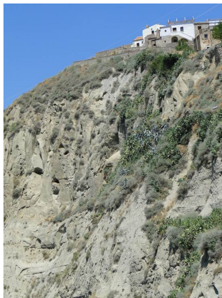
Fig. 5 – Versante sud sottostante il Museo, interessato da discontinuità strutturali, erosione e cavità antropiche.
